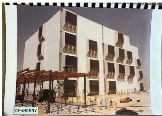
Figura 198: Fachada principal da Chancelaria em Riade. Fonte: Acervo do SARQ/MRE.
