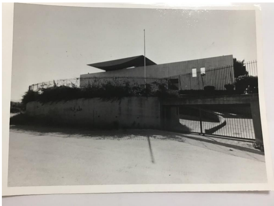
Figura 35: Fotografia antiga mostrando a solução definitiva para os muros de arrimo na fachada oeste. Fonte: Acervo do IMS/RJ.
