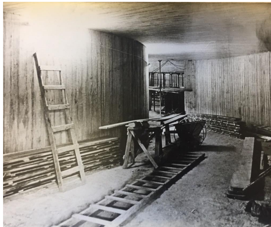
Figura 152: Fotografia da construção dos acessos ao subsolo. Fonte: Acervo do SARQ/MRE.
