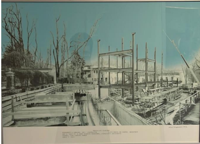
Figura 97: Fotomontagem ilustrativa da construção do edifício da Chancelaria, presente nos saguões da Embaixada. Fonte: Registrado por Paulo César Braga (2024).
