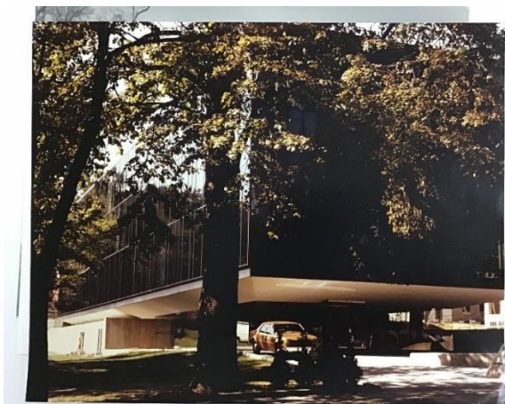
Figura 103: Fotografia a partir da Massachusetts Avenue, que ilustra o acesso de veículos ao nível térreo da Chancelaria e o recuo em relação à fachada principal. Fonte: Acervo do SARQ/MRE.
