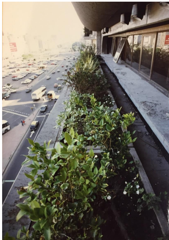
Figura 148: Fotografia detalhando as varandas e as janelas, nos pavimentos. Fonte: Acervo SARQ/MRE.
