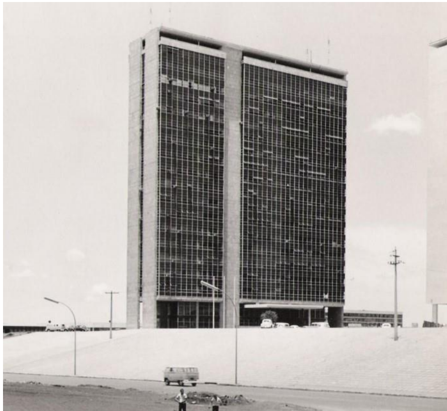
Figura 10: Edifício do BNDES em Brasília, ainda em construção. Disponível em: http://elvindubugras.blogspot.com/ . Acesso em: 14/04/2020.
