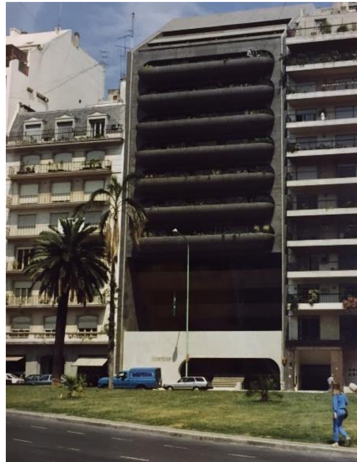
Figura 113: Fotografia da fachada principal, mostrando a guarita no térreo, o recuo nos primeiros pavimentos, as varandas e o recuo nos últimos pisos. Fonte: Acervo do SARQ/MRE.
