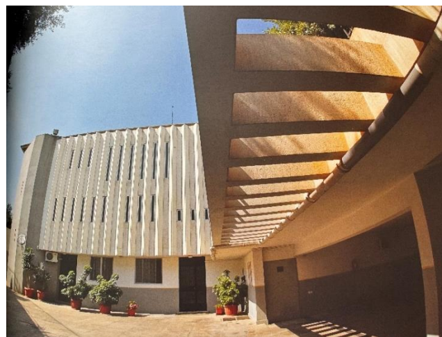
Figura 43: Fachada norte com as janelas do tipo seteira nos pavimentos e o acesso à zona de serviço no pavimento semi-enterrado. Fonte: Ministério das Relações Exteriores, 2003.
