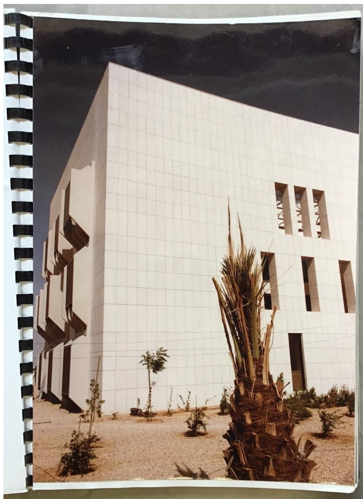
Figura 199: Vista da fachada lateral direita da Chancelaria. Fonte: Acervo do SARQ/MRE.
