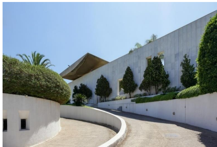
Figura 14: Muro de arrimo revestido em mármore que se volta à fachada oeste do projeto e protege o jardim privativo disposto na fachada sul. Fonte: Archdaily.
