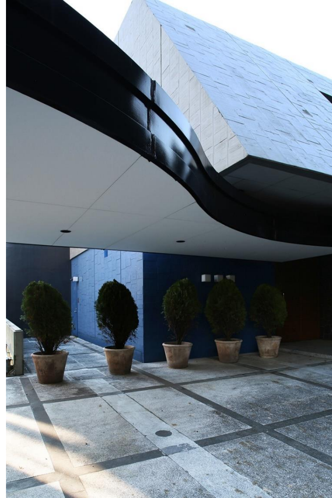
Figura 253: Detalhe do acesso ao edifício da Residência. Fonte: Disponível em www.ohtake.com.br .
