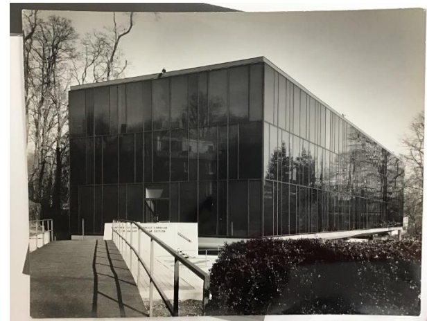
Figura 101: Fotografia do acesso posterior ao edifício da Chancelaria, a partir do estacionamento de servidores. Fonte: Acervo do IMS/RJ.
