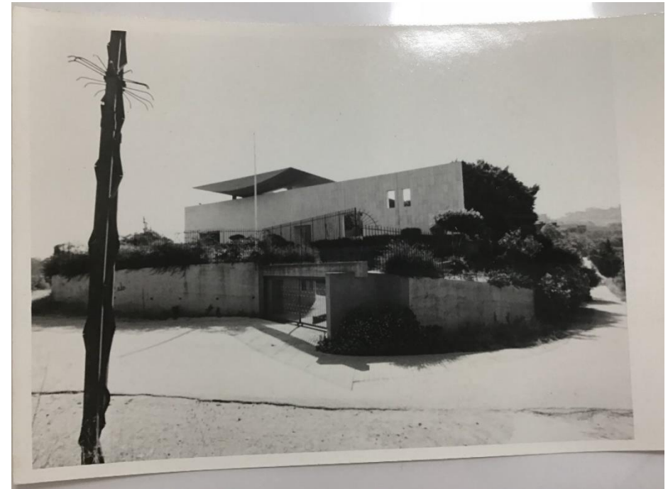
Figura 34: Fotografia antiga mostrando a solução definitiva para os muros de arrimo na fachada oeste. Fonte: Acervo do IMS/RJ.
