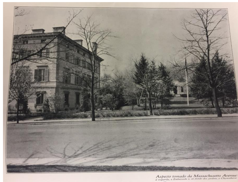
Figura 94: Fotografias antigas da fachada lateral do Palácio McCormick e do terreno vazio ao lado onde, futuramente, se instalaria o edifício da Chancelaria projetado por Redig de Campos. Note-se ao fundo o antigo edifício onde se realizavam as funções administrativas e burocráticas anteriormente, que foi demolido. Fonte: Acervo do SARQ/MRE.
