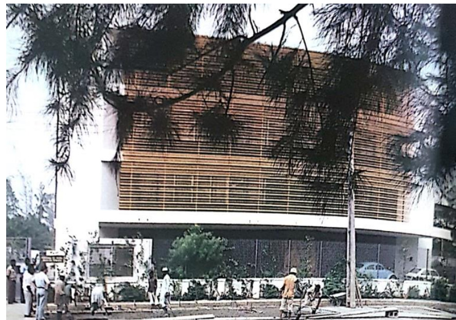
Figura 167: Fotografia da fachada principal à época da construção. Fonte: Revista Projeto.
