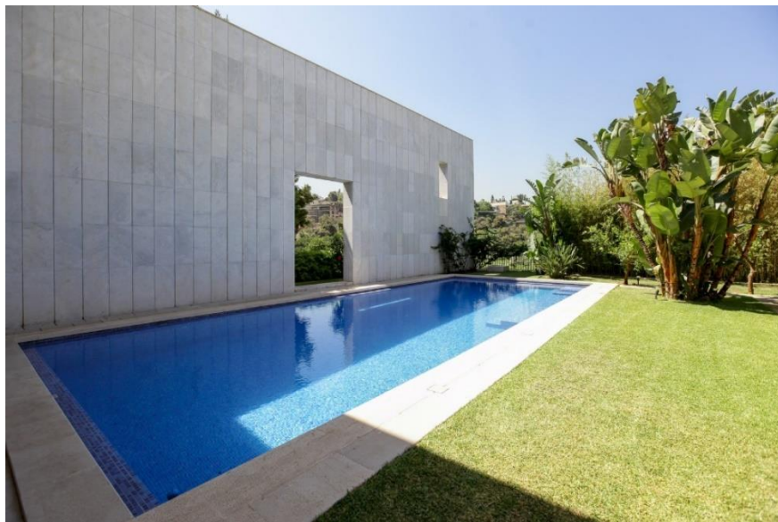
Figura 37: Vista da piscina a partir do jardim interno, na porção sul do terreno. Note-se o muro de arrimo que delimita a fachada leste, com as aberturas em formato retangular coincidentes com a paginação do mármore branco. Fonte: Archdaily.com
