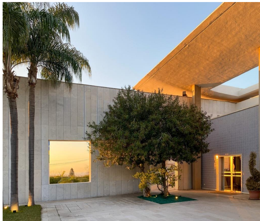
Figura 40: Vista do muro de arrimo que delimita a fachada oeste do projeto e garante privacidade à zona do jardim e da piscina. À direita, a fachada sul do projeto. Acima, a cobertura côncava em concreto armado. Fonte: Archdaily.com
