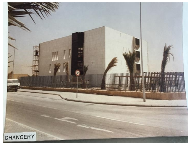
Figura 197: Vista das fachadas posterior e lateral direita a partir da via de acesso à Chancelaria. Fonte: Acervo do SARQ/MRE.
