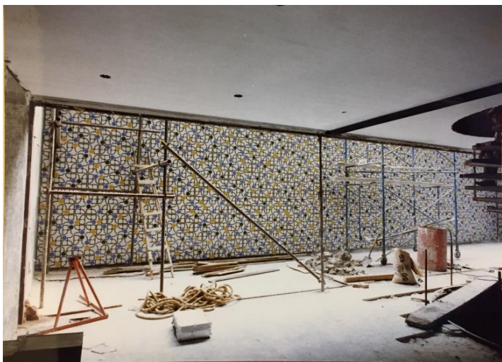
Figura 149: Fotografia da etapa de acabamentos no térreo da Chancelaria. Note-se a instalação do painel em azulejos de autoria de Athos Bulcão. Fonte: Acervo do SARQ/MRE.
