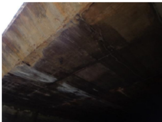
Figura 266.a - E.A.R Encabeçamento do viaduto
