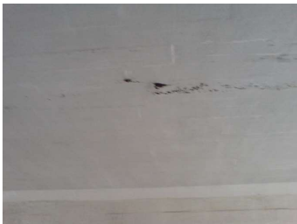
Figura 273.b – E.A.P.R – Revestimento laje
