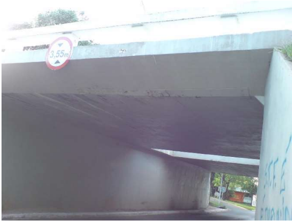
Figura 101.b - E.A.P.R - Tabuleiro após reforma
