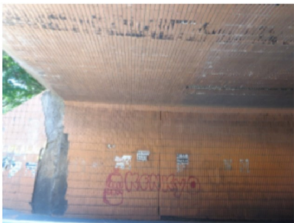
Figura 146.a - E.A.R - cortina de concreto
