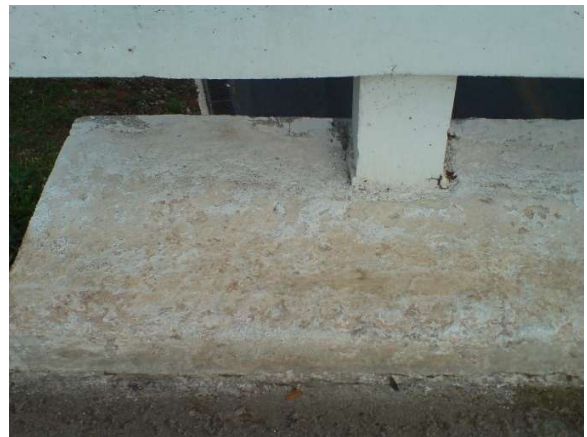
Figura 34. b - E.AP.R - Guarda roda após reforma
