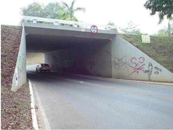
Figura 245.b - E.AP.R - Tabuleiro após reforma
