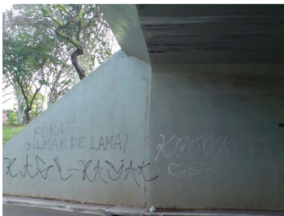
Figura 201.b – E.A.P.R Junta da cortina de concreto
