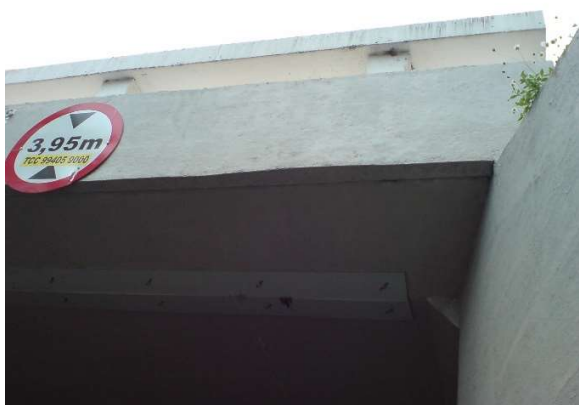
Figura 269.b – E.AP. R Encabeçamento do viaduto
