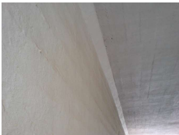
Figura 223.b – E.A.P.R Cortina de Concreto
