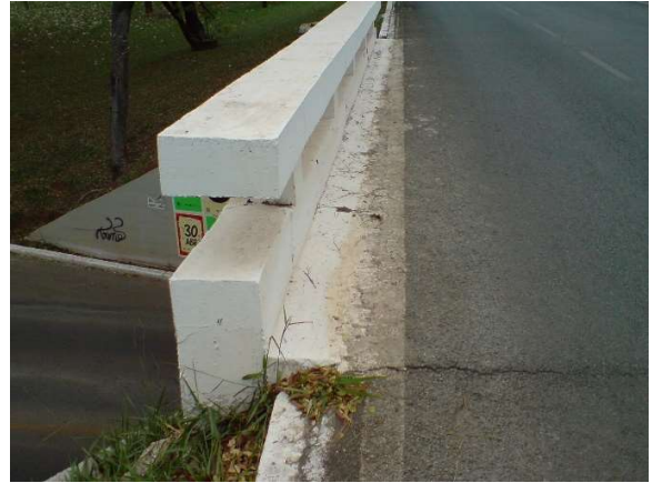
Figura 250.b - E.A.P.R - Guarda roda após reforma
