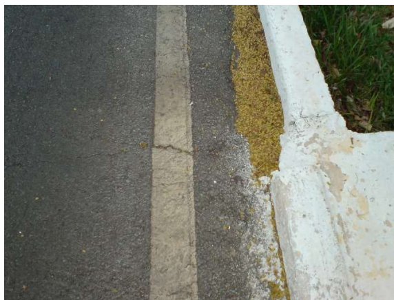
Figura 274.b - E.A.P.R - Guarda roda
