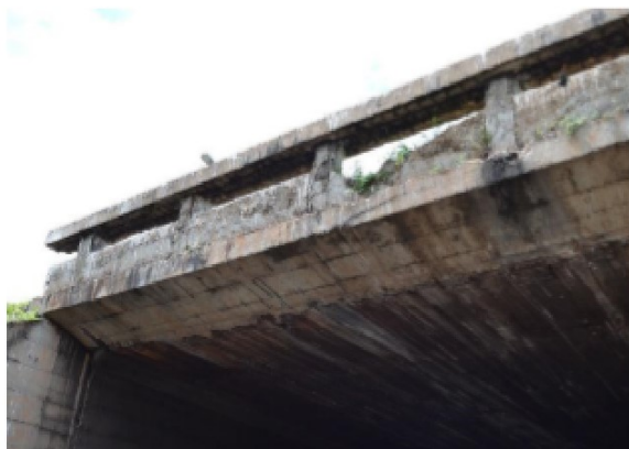
Figura 386.a - E.A.R Guarda roda e encabeçamento do viaduto
