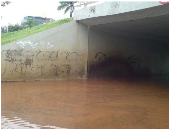
Figura 365.a - E.A.R Encabeçamento do viaduto
