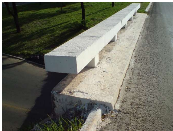
Figura 176.b - E.AP.R - Guarda roda após reforma
