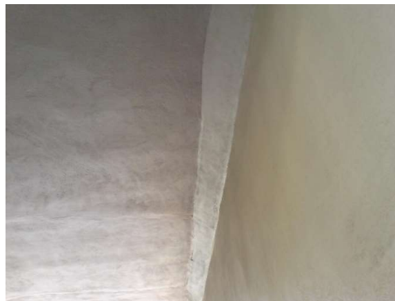
Figura 150.b – E.AP.R Cortina de Concreto
