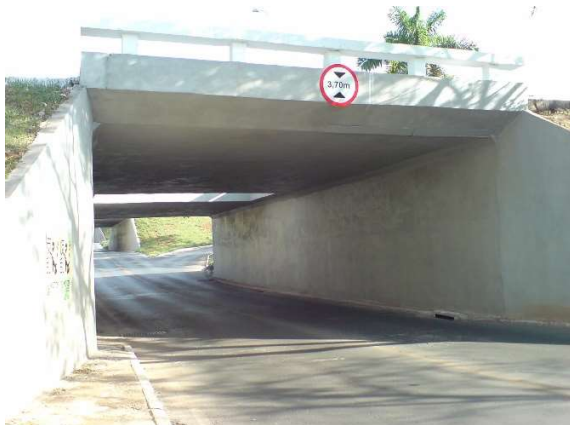
Figura 173.b - E.AP.R - Tabuleiro após reforma
