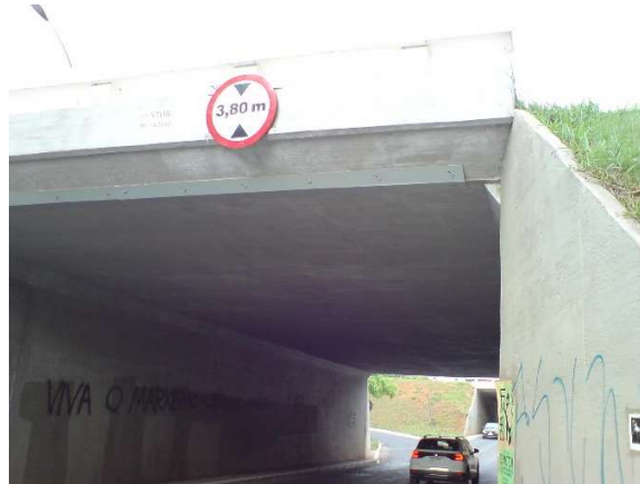
Figura 294.b – E.AP. R Encabeçamento do viaduto
