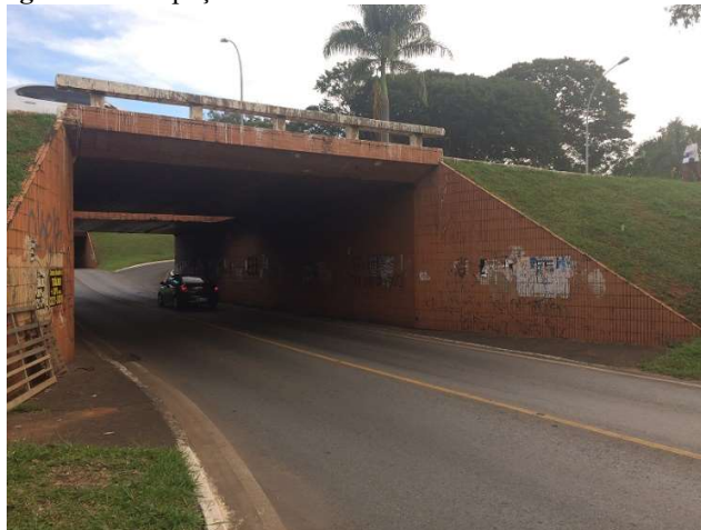
Figura 11 - Inspeção visual do viaduto da 215/216 sul
