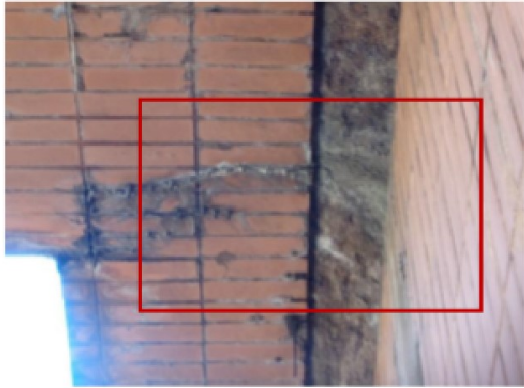
Figura 26.a – E.A.R Cortina de Concreto do viaduto
