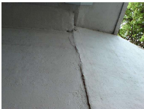
Figura 343.b – E.AP.R Encabeçamento e junta do viaduto
