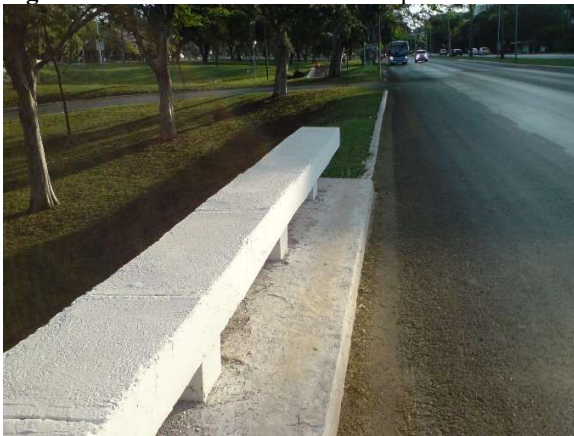
Figura 81.b - E.AP.R - Guarda roda após reforma
