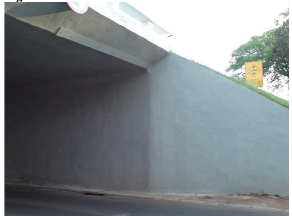
Figura 82.b – E.AP.R Cortina de Concreto do Viaduto
