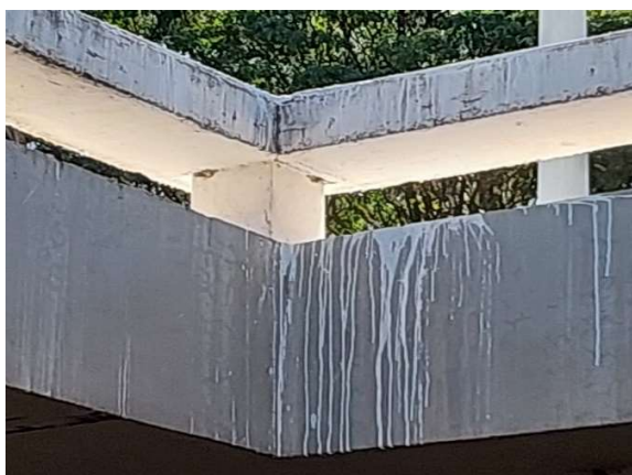
Figura 177.b - E.AP.R - Guarda roda após reforma
