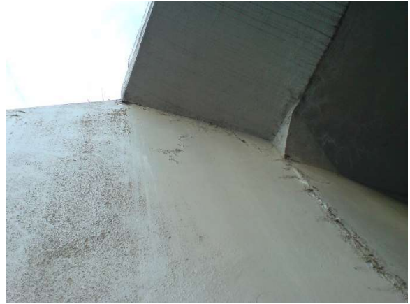
Figura 106.b – E.AP.R Cortina de concreto
