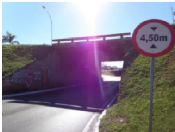
Figura 363.a - E.A.R Guarda roda do viaduto
