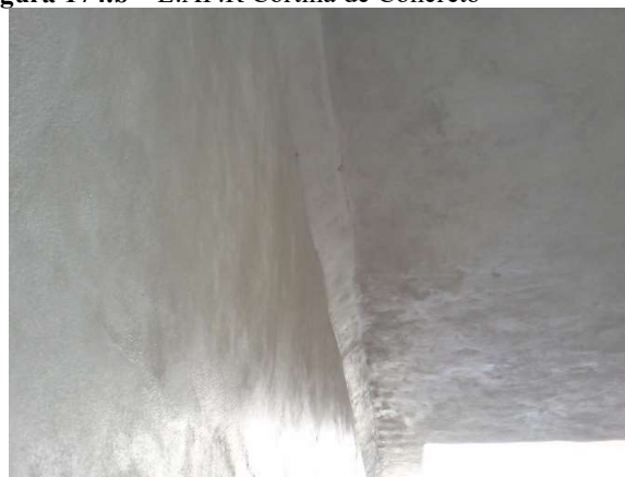
Figura 174.b – E.AP.R Cortina de Concreto
