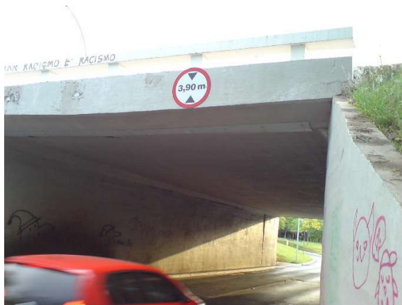
Figura 341.b – E.AP.R Encabeçamento do viaduto
