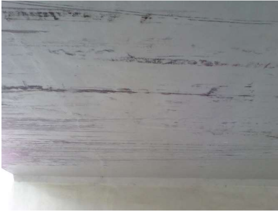
Figura 57.b - E.A.P.R - Tabuleiro após reforma
