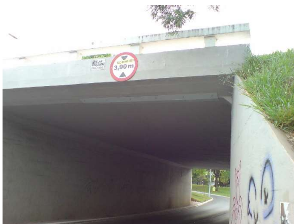
Figura 317.b – E.AP.R Encabeçamento do viaduto
