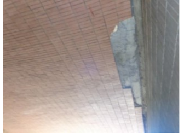
Figura 99.a - E.A.R - cortina de concreto
