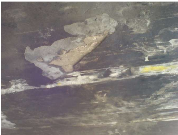
Figura 33.b - E.AP.R - Guarda roda após reforma
