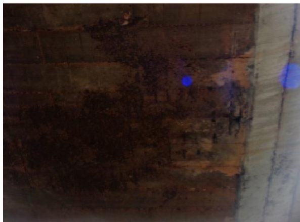
Figura 240.a - E.A.R Exposição e corrosão da armadura
