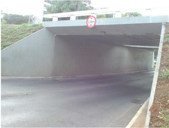
Figura 53.b - E.A.P.R - Tabuleiro após reforma
