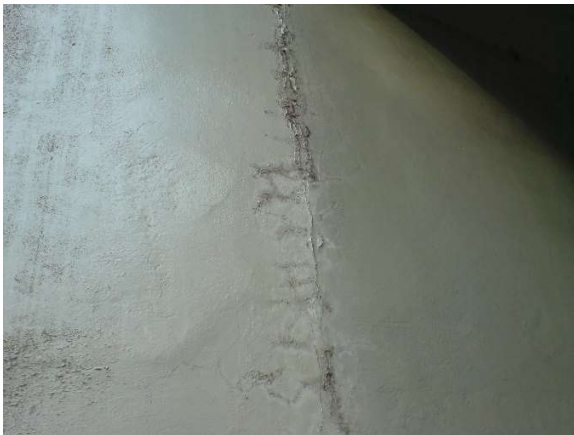
Figura 103.b – E.A.P.R Junta Cortina de Concreto
