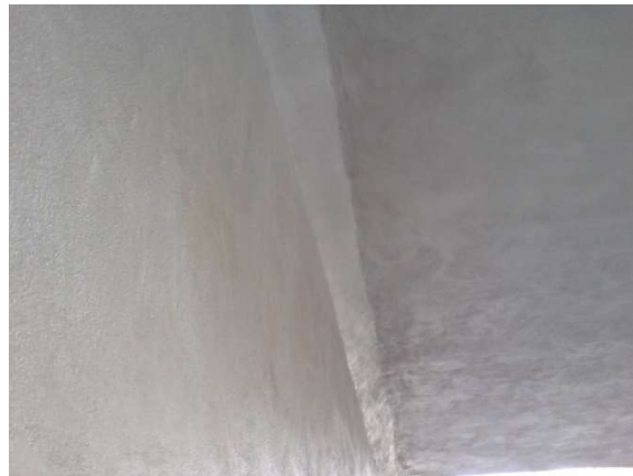
Figura 126.b – E.A.P.R Cortina de Concreto do viaduto
