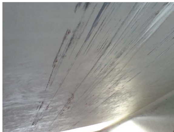
Figura 200.b – E.A.R – Revestimento tabuleiro
