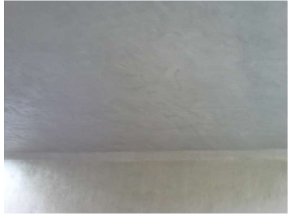
Figura 80.b – E.A.R – Revestimento tabuleiro
