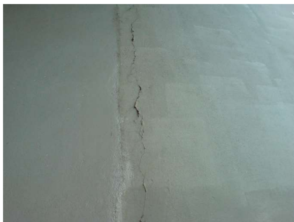
Figura 153.b – E.A.P.R Junta da Cortina de concreto
