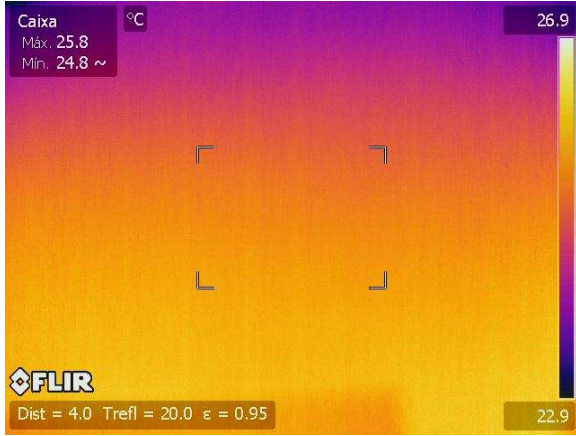
Figura 371.c - TM.P.S - Termográfica encabeçamento do viaduto
