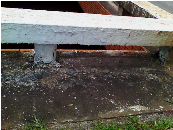
Figura 19.a - Guarda-corpo 02 do viaduto
