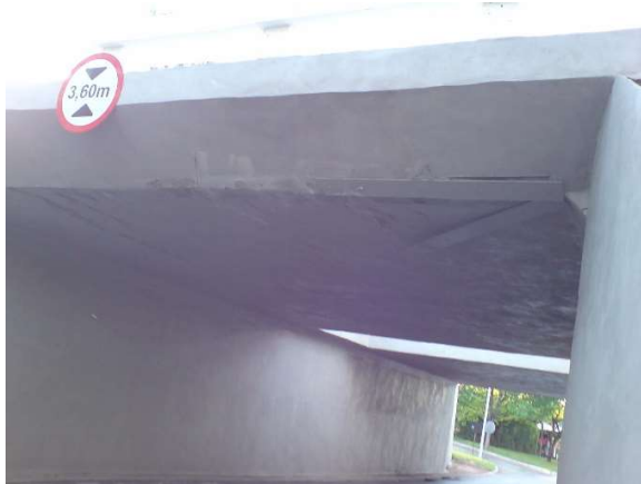
Figura 77.b - E.AP.R - Tabuleiro após reforma
