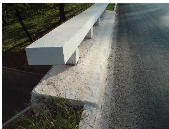
Figura 130.b - E.AP.R - Guarda roda após reforma
