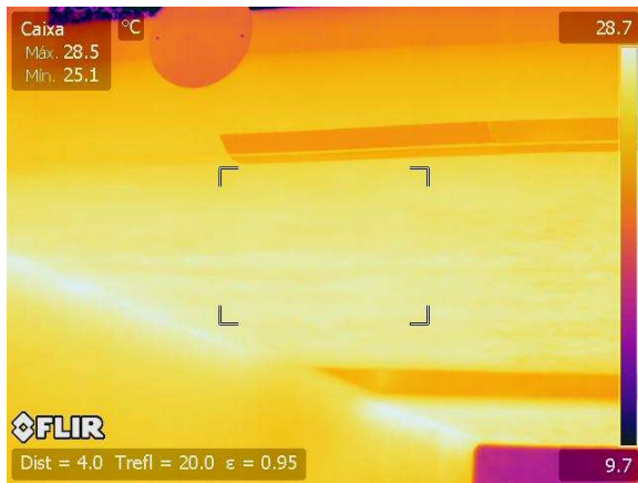
Figura 35.c – TM.P.S - Termográfica tabuleiro
