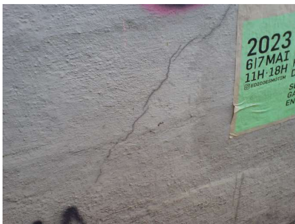
Figura 271.b – E.A.P.R Cortina de concreto
