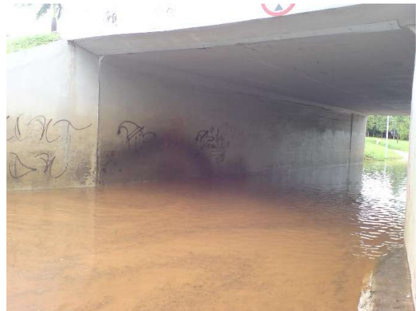
Figura 366.a - E.A.R Encabeçamento do viaduto
