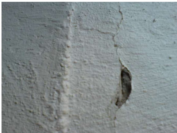
Figura 319.b – E.AP. R Junta da cortina de concreto
