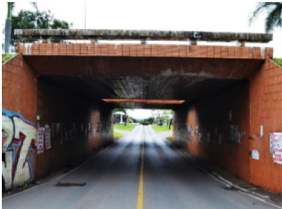
Figura 24.a - E.A.R Revestimento cerâmico viaduto
