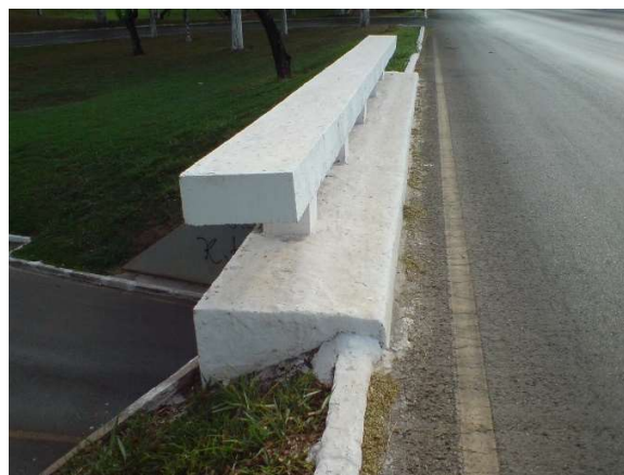
Figura 202.b - E.A.P.R - Guarda roda após reforma
