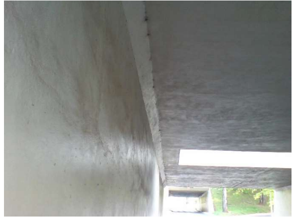
Figura 102.b – E.A.P.R Cortina de Concreto do viaduto
