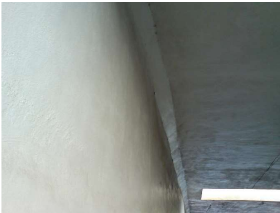
Figura 55.b - E.A.P.R - Cortina de concreto
