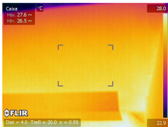
Figura 155.c – TM.P.S - Termográfica tabuleiro
