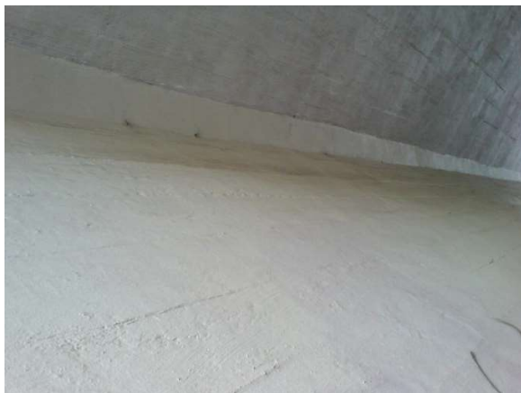
Figura 391.a - E.A.R Cortina de concreto
