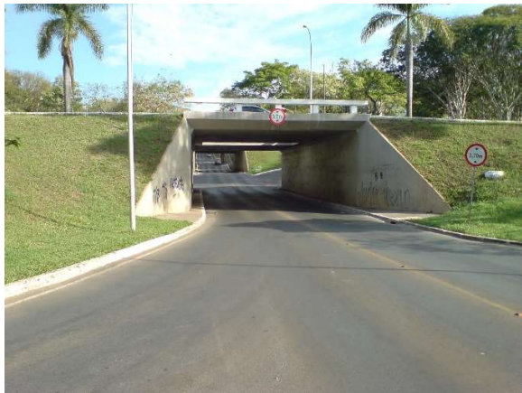
Figura 197.b - E.A.P.R - Tabuleiro após reforma
