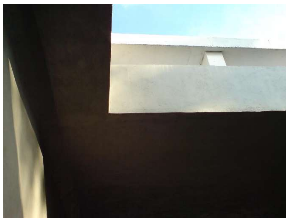
Figura 128.b - E.AP.R - Guarda roda após reforma
