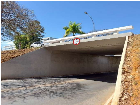
Figura 125.b - E.A.P.R - Tabuleiro após reforma
