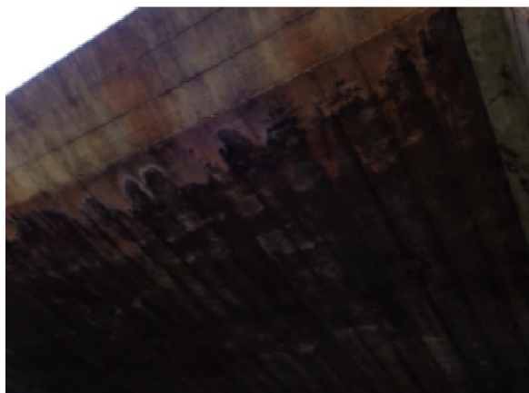
Figura 360.a - E.A.R Encabeçamento do viaduto
