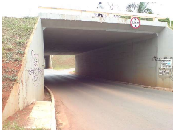
Figura 221.b - E.AP.R - Tabuleiro após reforma
