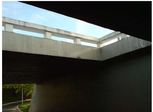
Figura 104.b - E.A.P.R - Guarda roda após reforma
