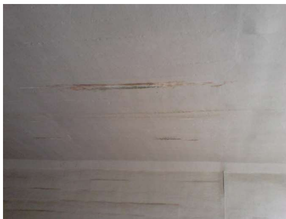
Figura 224.b – E.A.R – Revestimento tabuleiro
