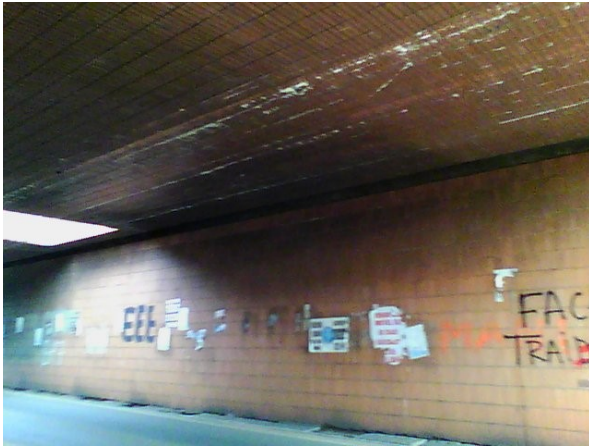
Figura 20.a - Cortina de concreto do viaduto
