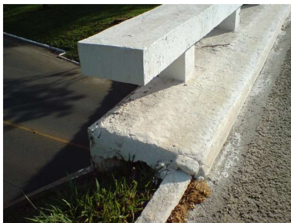
Figura 154.b - E.A.P.R - Guarda roda após reforma
