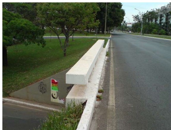
Figura 298.b - E.A.P.R - Guarda roda após reforma
