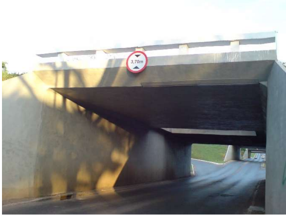
Figura 29.b - E.A.P.R - Tabuleiro após reforma
