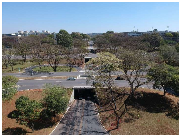
Figura 15 - Vista frontal do Viaduto da 215/216 Sul
