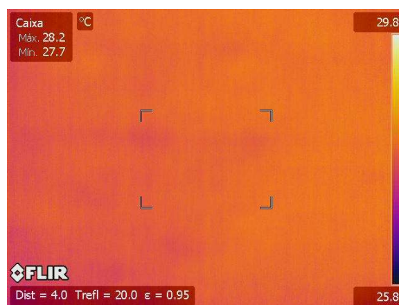
Figura 230.c - TM.P.S - Termográfica Tabuleiro
