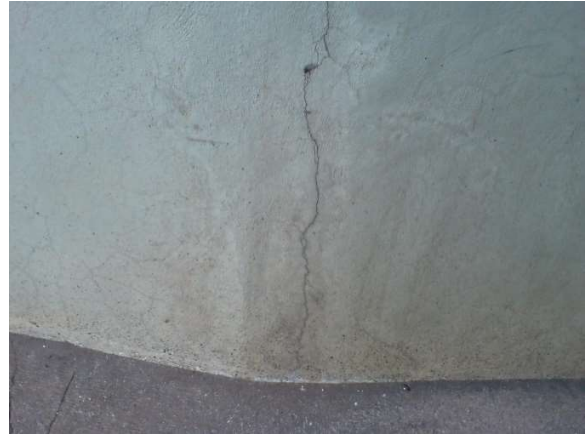
Figura 58.b - E.A.P.R - Junta da cortina
