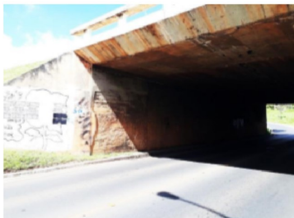
Figura 336.a - E.A.R Acesso ao viaduto
