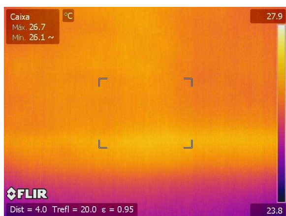
Figura 189.d – TM.P.U Cortina de concreto
