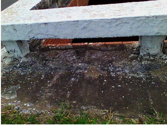
Figura 18.a - Guarda-corpo 1 do viaduto
