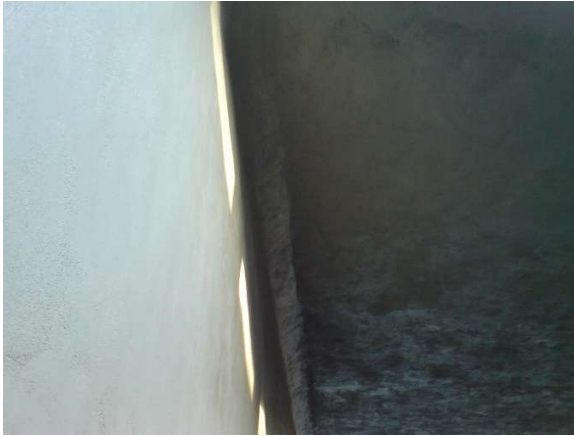
Figura 79.b - Cortina de Concreto do Viaduto
