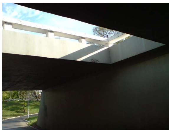
Figura 152.b - E.AP.R - Guarda roda após reforma
