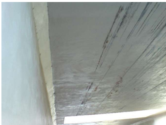
Figura 199b – E.A.P.R Cortina de Concreto
