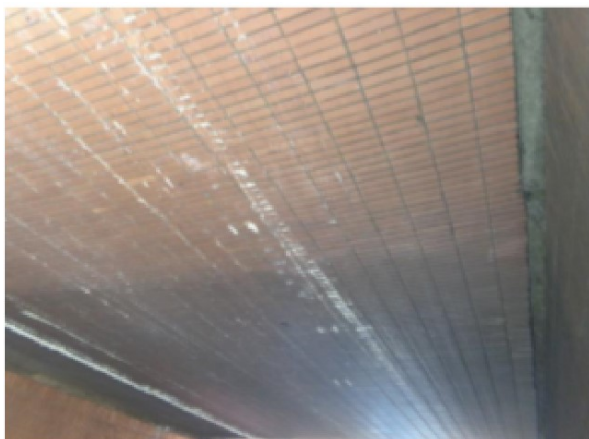
Figura 122.a - E.A.R – Cortina de concreto
