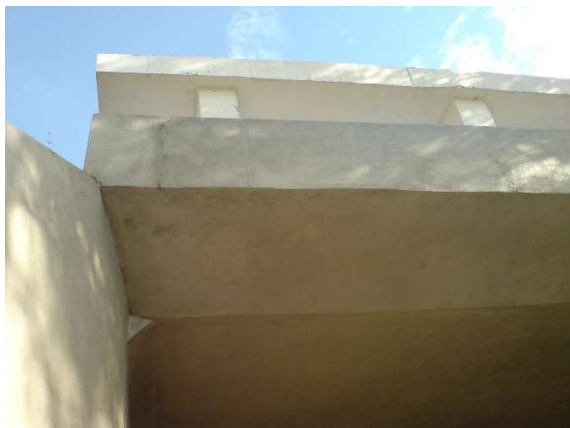
Figura 175.b – E.AP.R Junta da cortina de concreto
