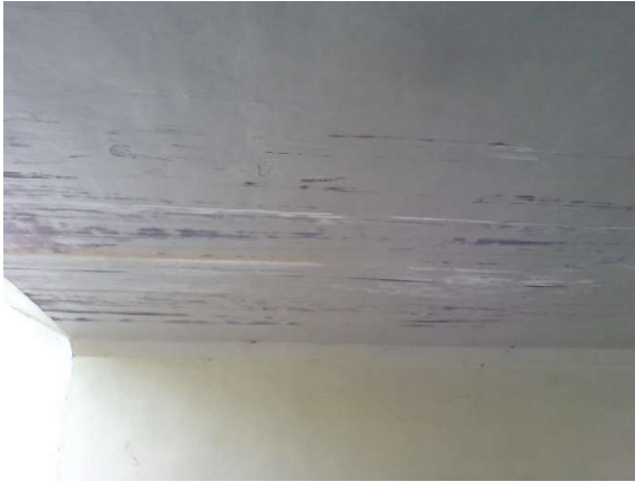
Figura 105.b – E.A.R – Revestimento tabuleiro
