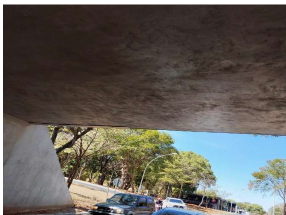
Figura 178.b – E.A.R – Revestimento tabuleiro
