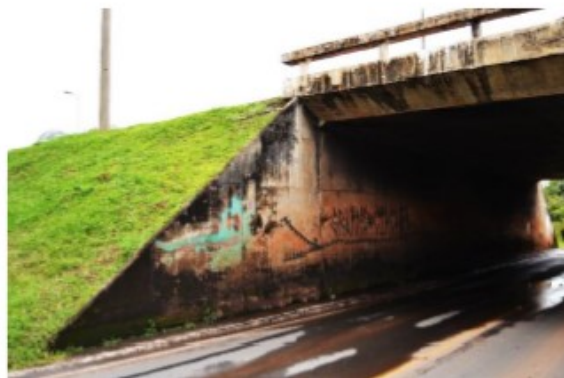
Figura 385.a - E.A.R Encabeçamento do viaduto
