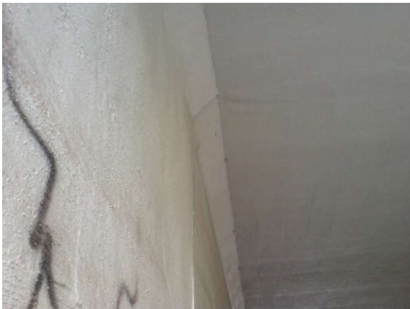
Figura 247.b – E.AP.R Cortina de Concreto
