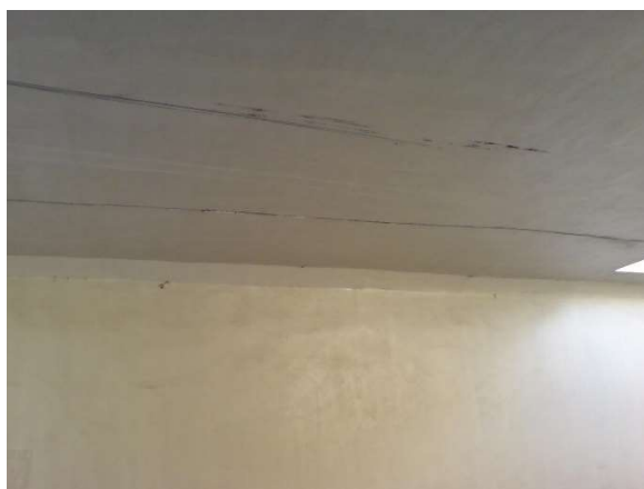
Figura 151.b – E.A.R – Revestimento tabuleiro
