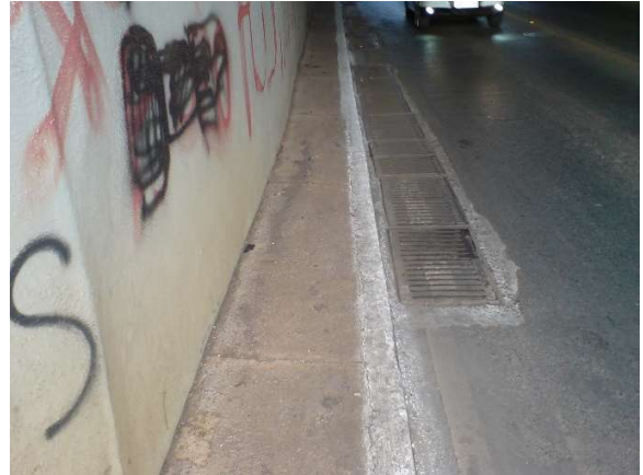
Figura 346.b – E.AP.R Passagem de pedestre
