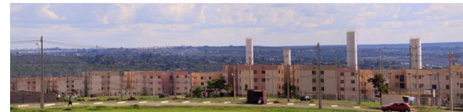
Figura 104: Condomínio Paranoá Parque. Blocos de quatro pavimentos que alcançam uma altura de 11,60m e suas caixas d'água com 15 m de altura. Fonte: Acervo pessoal da autora.
