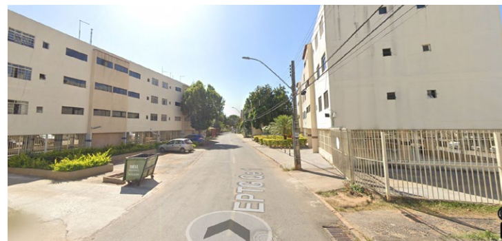
Figura 9: Vista atual das QELC, implantadas em 1987. Fonte: GoogleMaps.
