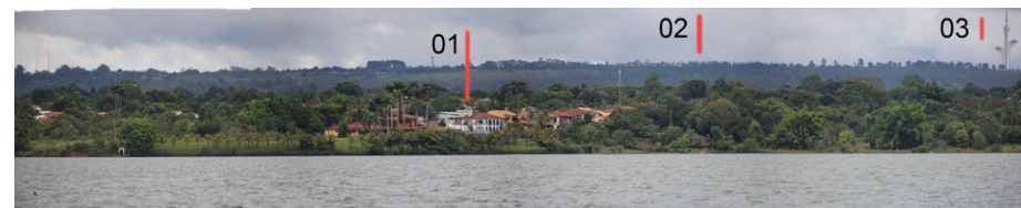
Figura 38: Ponto 7. No ponto 01 é possível visualizar o Setor de Habitações Individuais Norte, no ponto 02 a linha de cumeeira da Bacia Hidrográfica do Paranoá e no ponto 03 a Torre de TV digital. Fonte: Acervo pessoal da autora.
