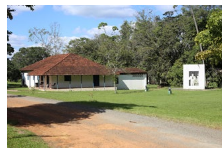
Figura 6. Casa Velha da Fazenda Gama. Fonte: Autora.
