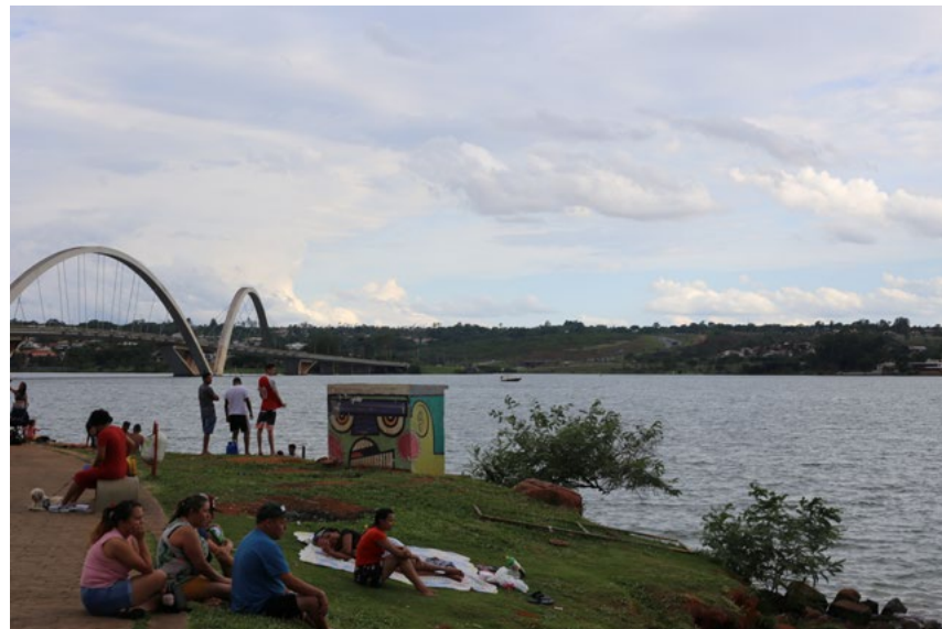
Figura 3. Ponte Juscelino Kubitschek. Fonte: Autora.
