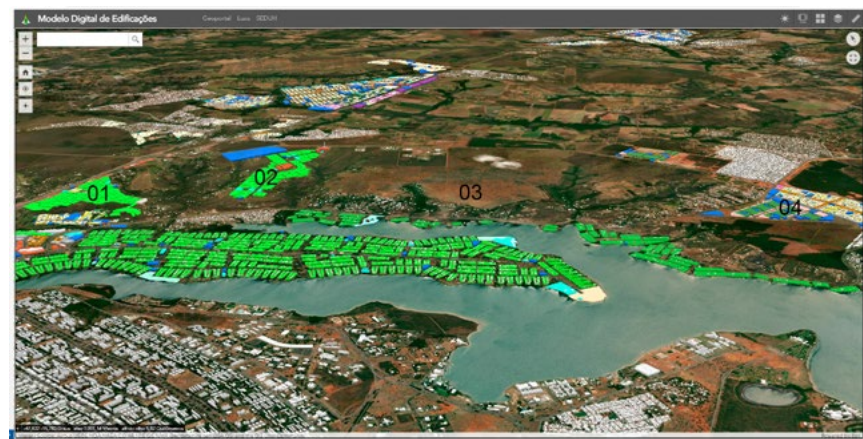
Figura 131: Setor Habitacional do Taquari. Na imagem se vê no Ponto 01 o Trecho 01 do SHTQ, já implantado; no ponto 02 se vê o Trecho 2 do SHTQ, ainda não implantado; no ponto 3 se vê área com previsão de novos loteamentos e no ponto 4, o Condomínio Paranoá Parque na Região Administrativa do Paranoá.
