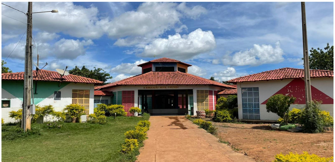
Figura 8 - Escola Municipal Deusdezino de Souza Ferreira após a reforma em 2023 Foto: Acervo pessoal
