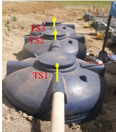
FIGURA 3. Vista dos três tanques sépticos (TS1, TS2 e TS3) indicando a direção do fluxo de esgoto.
