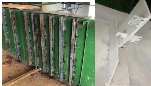
Figura 3.7. Enrijecimento do fundo do canal e o suporte confeccionado em aço
