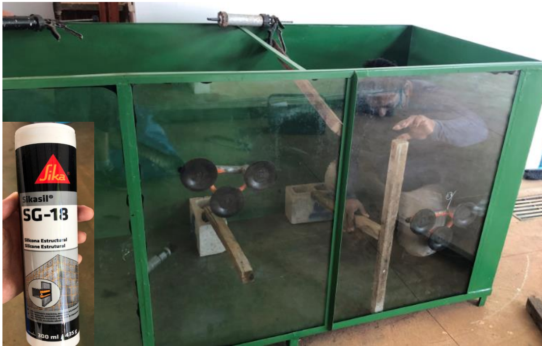
Fixação dos vidros com silicone estrutural cura de 7 dias para retirada de cimbramento
