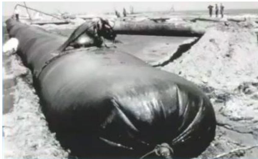
Figura 2.1. Tubo geotêxtil em execução - Holanda (Tencate-Geosynthetics, 1962)
