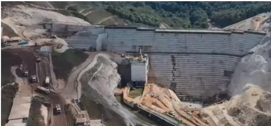
Figura 2.14. Barragem de CCR para contenção de rejeitos (VALINHAS e MOREIRA, 2020)
