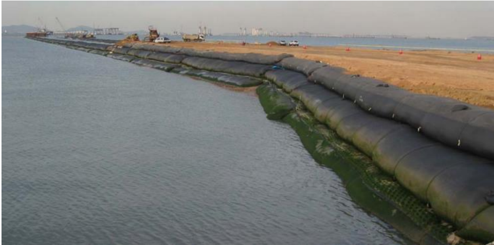
Figura 2.3 Colocação de preenchimento de terra dentro do dique de tubo geotêxtil no Projeto Incheon Bridge (Yee et al. ; 2008)
