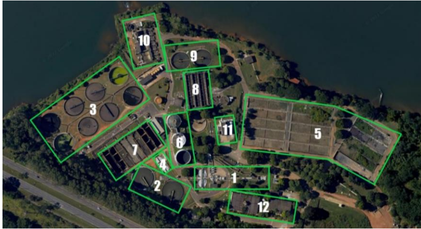
Figura 5.7- Unidades de tratamento de esgoto ETE Brasília Norte (imagem Google, 2024). (1) Tratamento preliminar; (2) Decantadores primários; (3) Decantadores secundários; (4) Adensadores; (5) Leitões de secagem; (6) Digestores; (7) Reatores biológico de nutrientes (aeróbio, anaeróbio e anóxico); (8) Tanque de equalização; (9) Adensadores por flotação; (10) Tanques de Polimento final; (11) Desidratação; (12) Administração e Laboratório.
