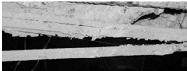
Ruptura por CCS ao longo do reforço induzida por fissura de flexão-cisalhamento
