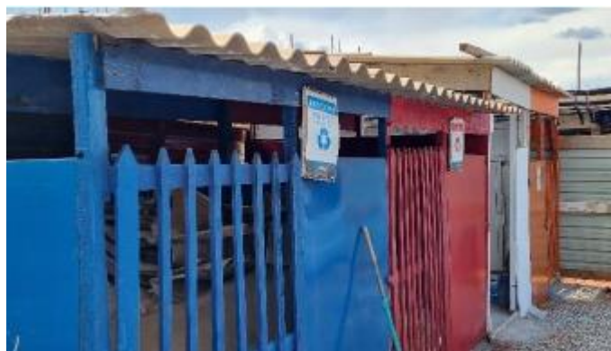
Figura 42 - Central para condicionamento dos resíduos (perigosos, papel, plástico, metal e madeira) da obra.
