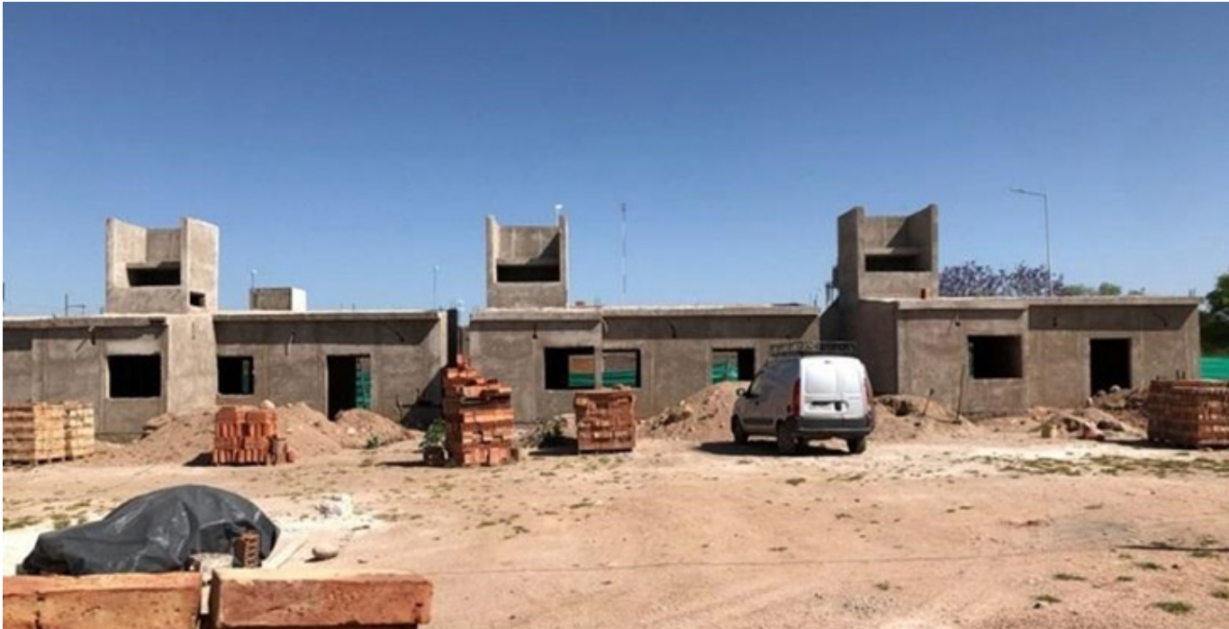
Figura 27: Construção das primeiras unidades do Renacer I em La Rioja em Janeiro de 2024. Fonte: Fundava, 2024.
