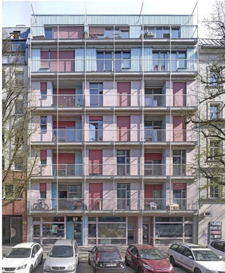
Figura 06: Conjunto habitacional LOVO (Berlim). Fonte: Christoph Wagner Arquitectos, 2024.
