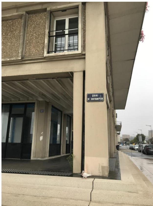
Figura 36 – Detalhes do concreto na fachada
