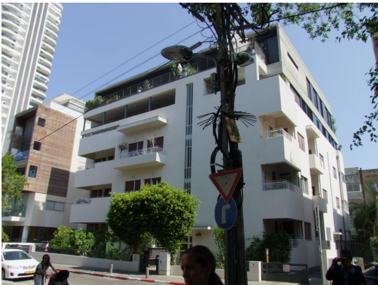
Figura 63 – Edificação com adição no último pavimento
