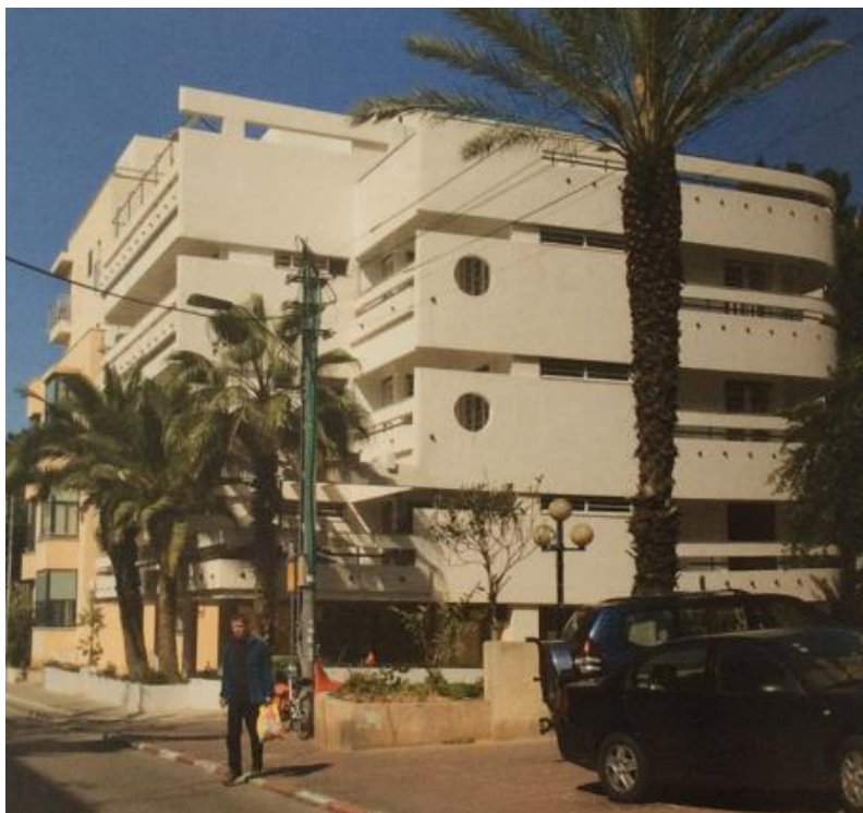
Figura 65 – Rubinsky House depois do restauro
