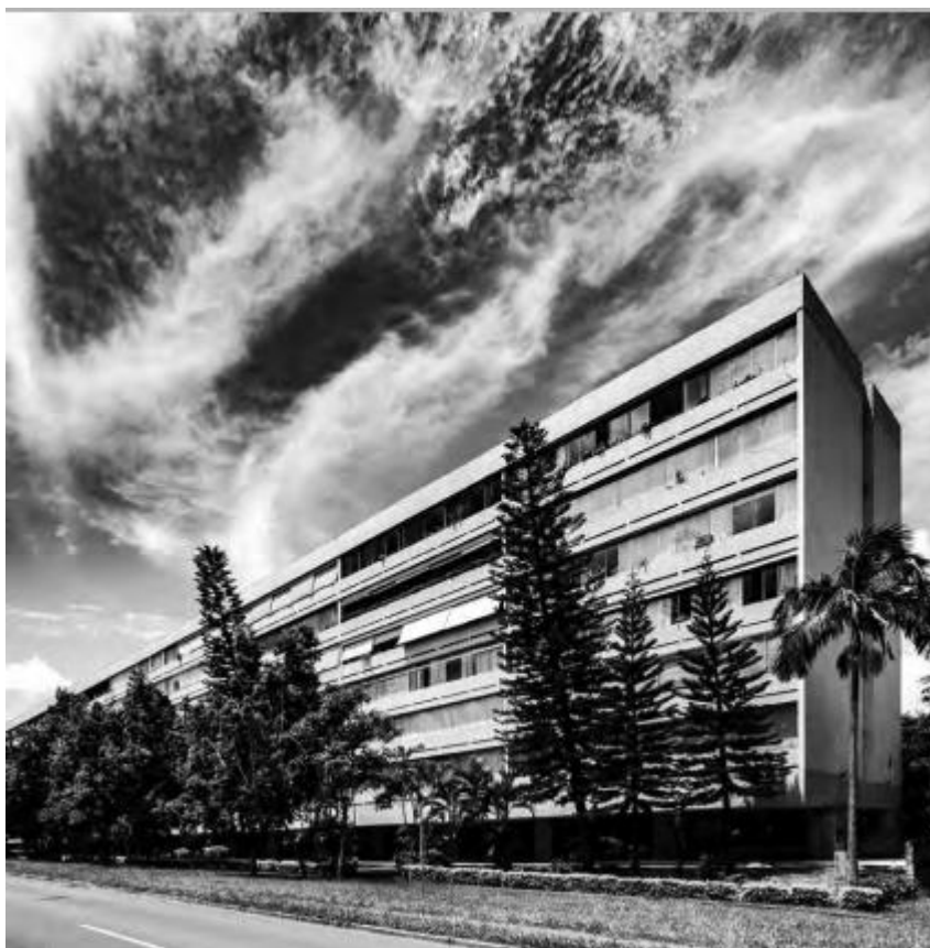
Figura 50 – Edifício na SQN 203
