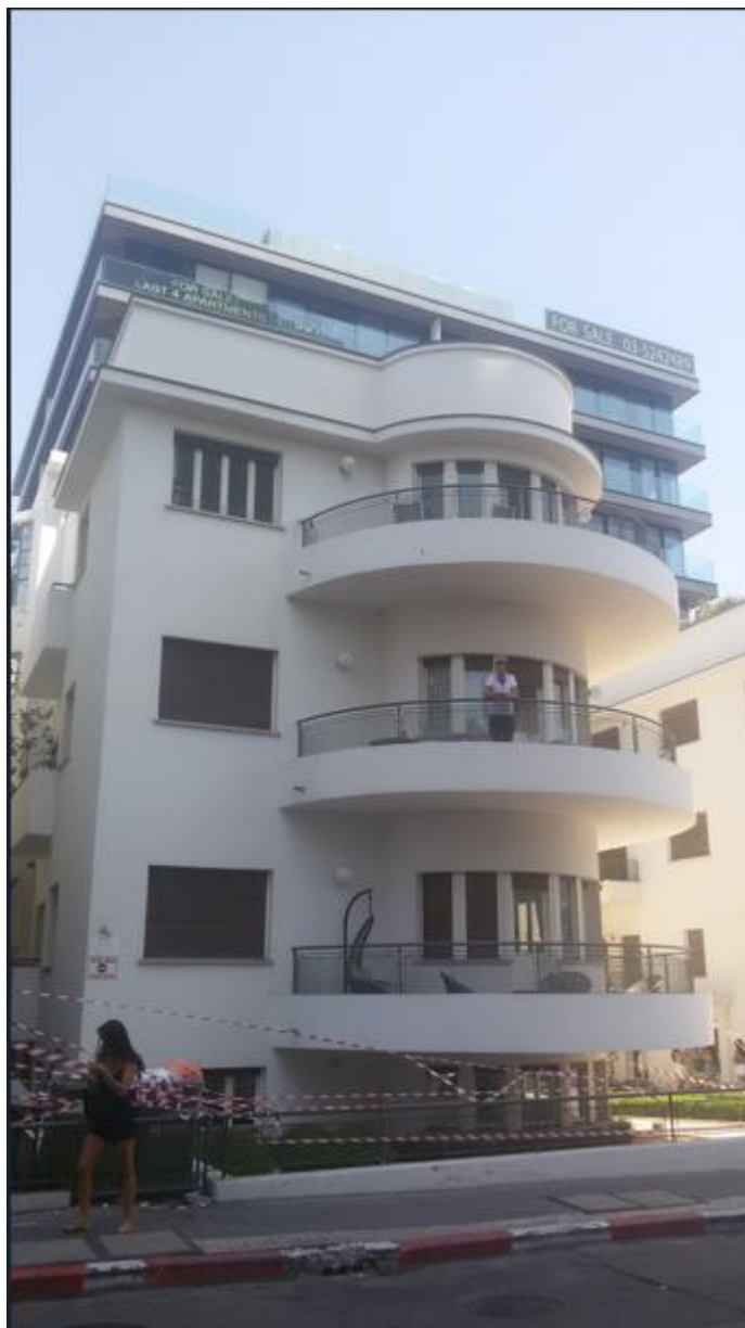
Figura 62 – Edifício com varanda em Tel Aviv e adição na parte posterior da edificação
