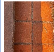
Figura 90 - Piso perímetro externo da EC.
