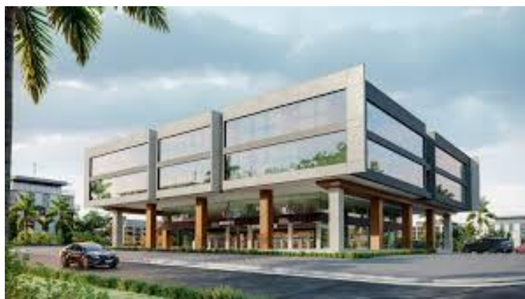
Figura 3 - Imagem do edifício A.
