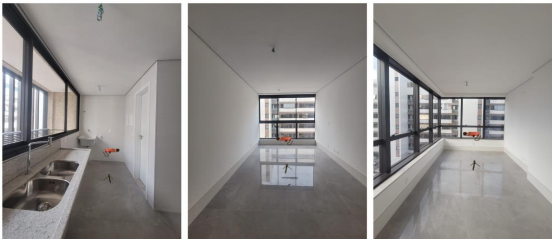
Figura 21 - Equipamento sendo utilizado nos apartamentos 101 e 106 do edifício B.
