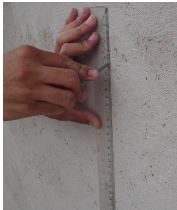
Foto 4.7 – Vista da realização do rasgo no revestimento.
