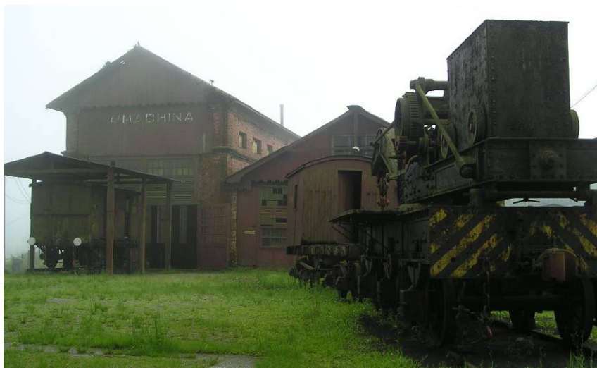
Figura 80 – Casa de Máquinas do 4º patamar do 1º sistema funicular. Foto: Anna Finger, 2007.
