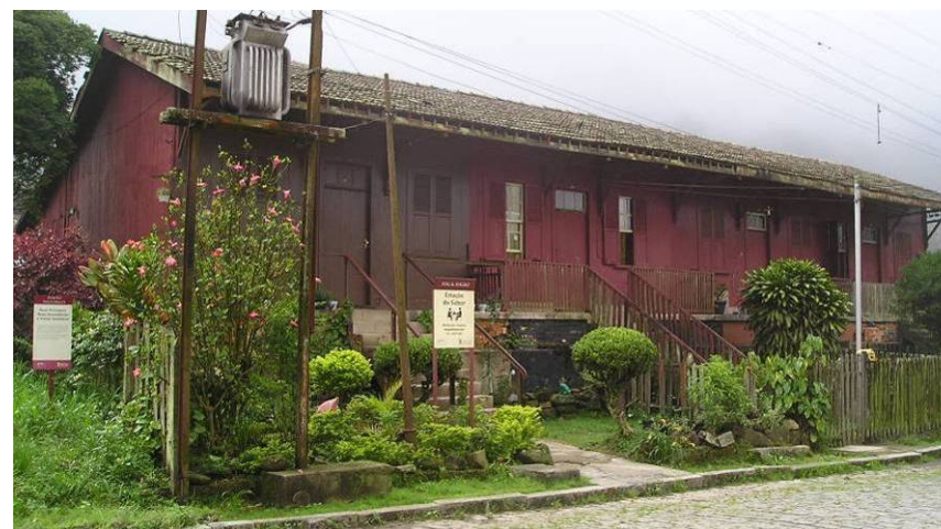
Figura 67 – Fachada da Tipologia “E1”
