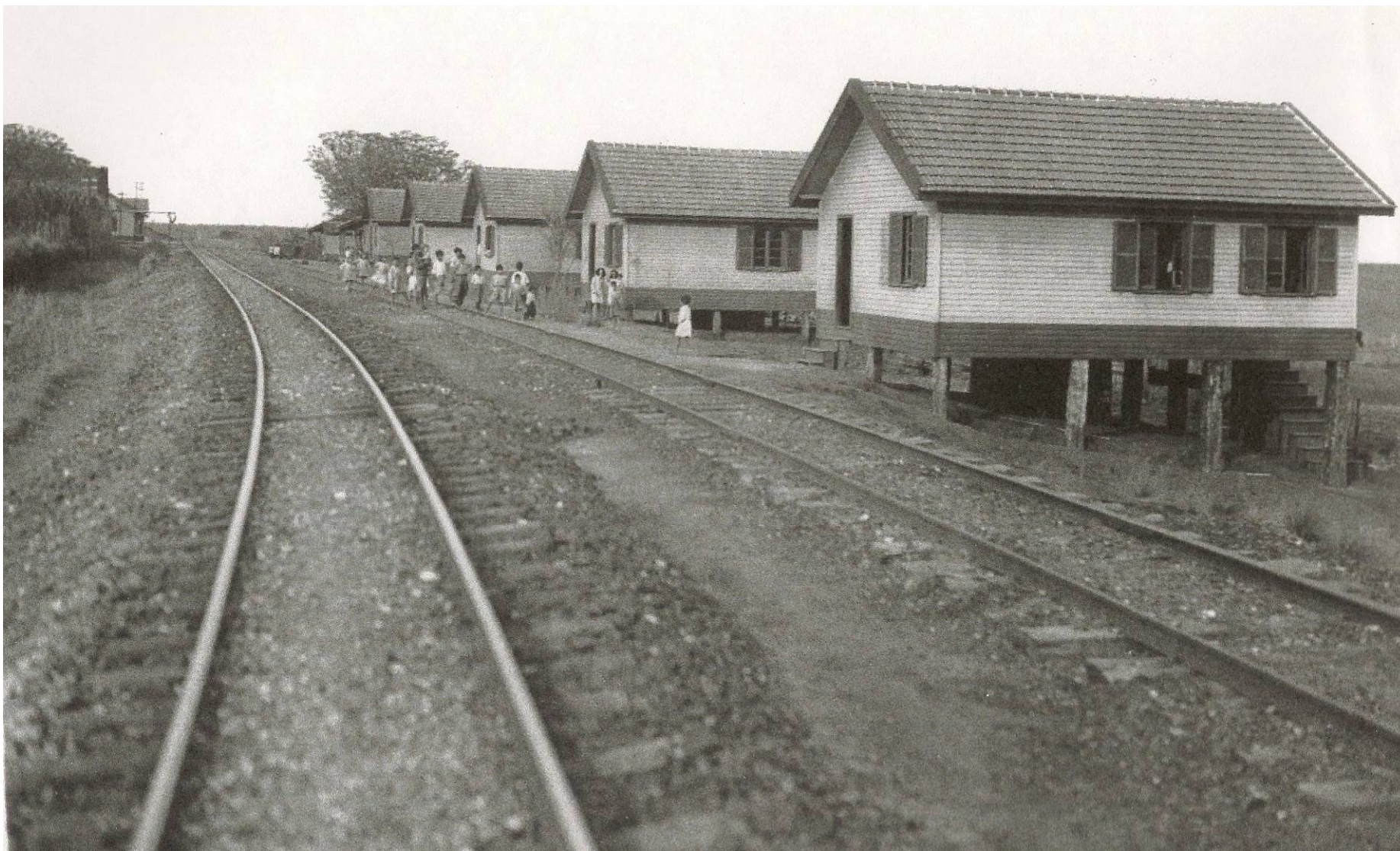
Habitações ao longo da linha férrea no Rio Grande do Sul.
