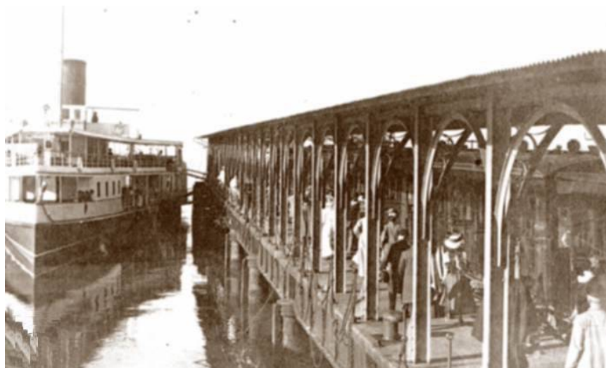
Figura 12 – Estação Guia de Pacobaíba. Detalhe da articulação entre o transporte ferroviário e aquaviário.
