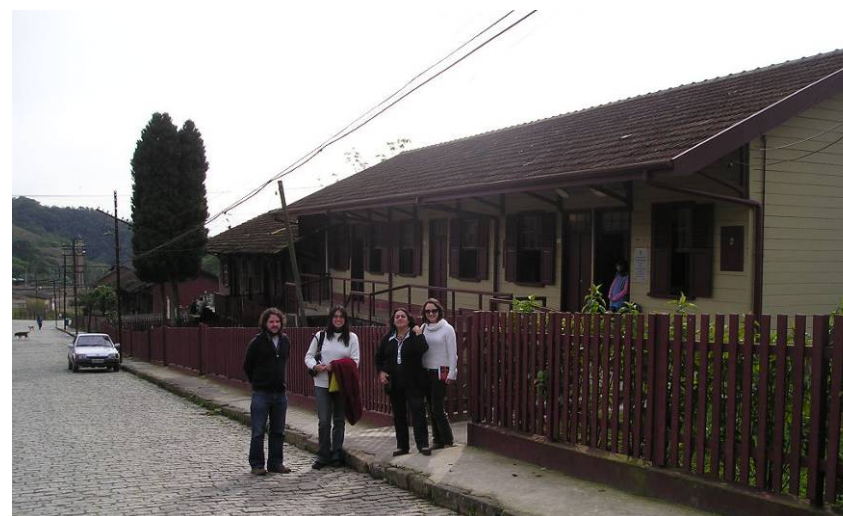
Figura 71 – Fachada da Tipologia “E2”.
