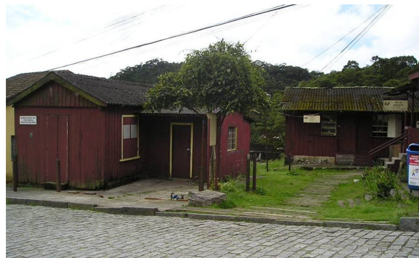
Figura 44 – Detalhe da configuração urbana e implantação dos edifícios na Vila Velha Foto: Anna Finger, 2008.
