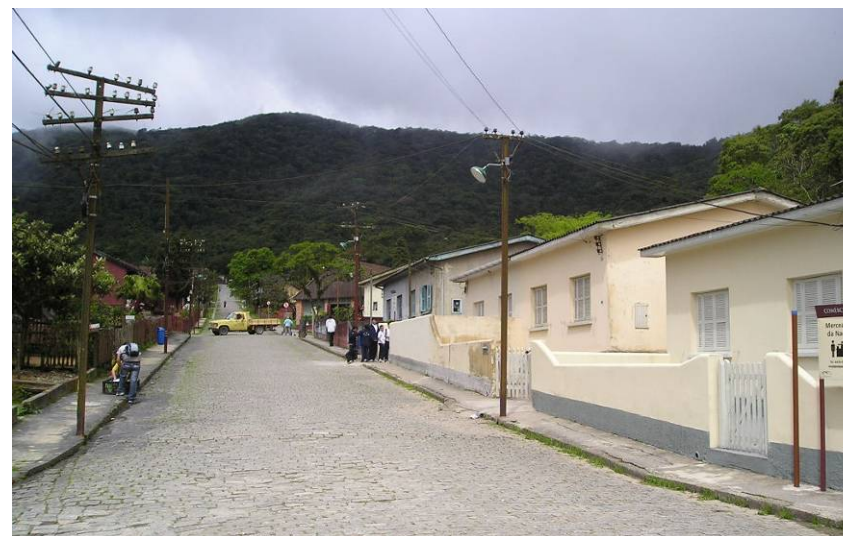
Figura 76 – Conjunto de edificações em alvenaria.
