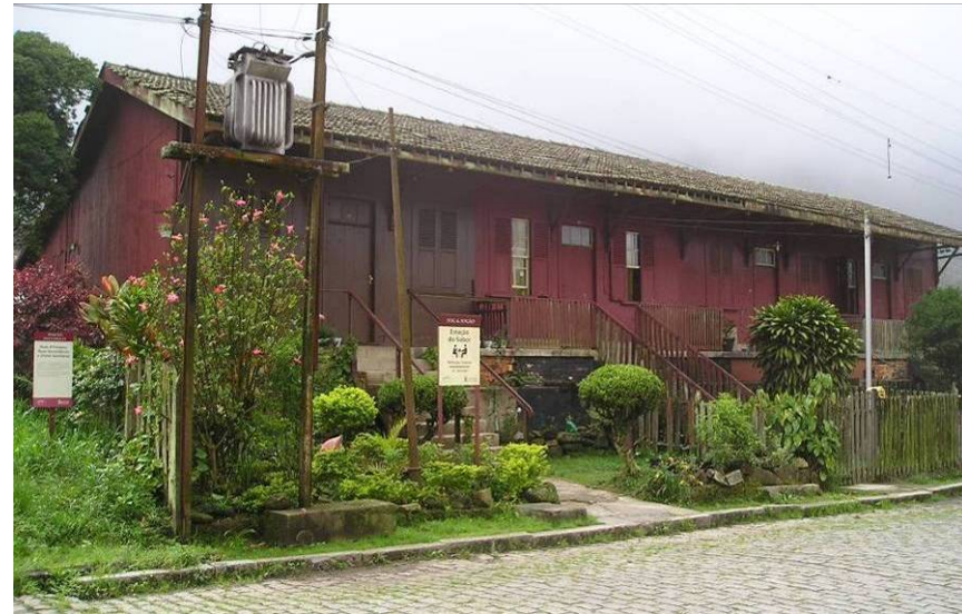
Figura 51 – Bloco de edificações residenciais.
