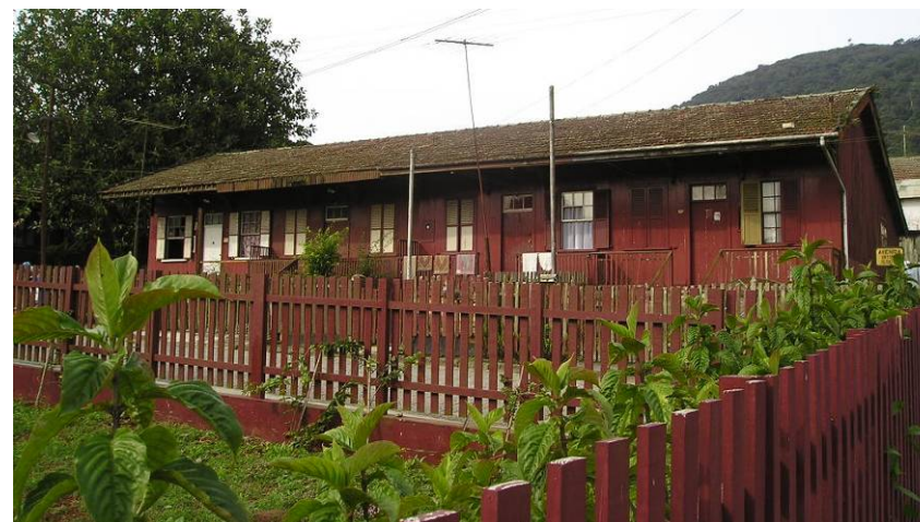
Figura 70 – Fachada da Tipologia “E2”.
