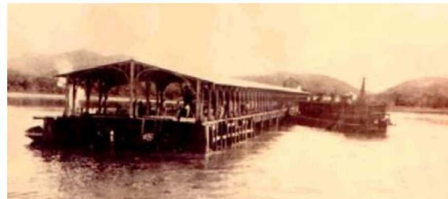
Figura 11 – Estação Guia de Pacobaíba, no fundo da Baía da Guanabara, inaugurada em 1854. Disponível em: http://br.geocities.com/praiademaua/FotosHistoricas/caisguiapacopaiba.jpg . Acesso em 25/10/2009.
