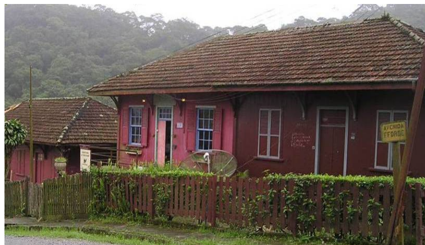
Figura 63 – Fachada da Tipologia “B”.
