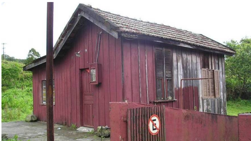
Figura 54 – Edificação residencial isolada na Vila Velha Foto: Anna Finger, 2008.
