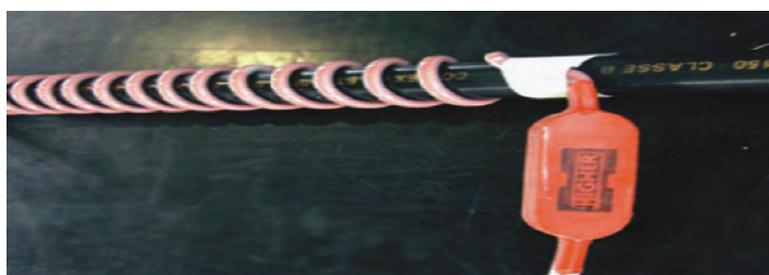
Figura 57 – Traço térmico enrolado na tubulação de alimentação de combustível.
