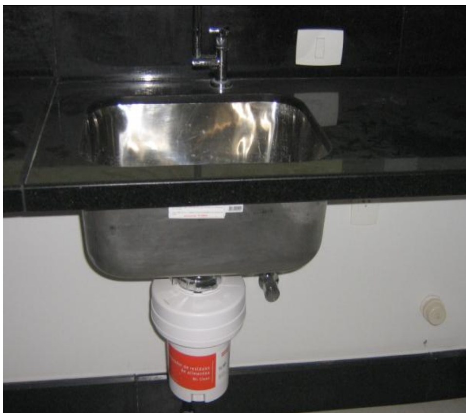
Figura 14: Triturador de resíduos da cozinha de um dos apartamentos do Ilhas do Lago
