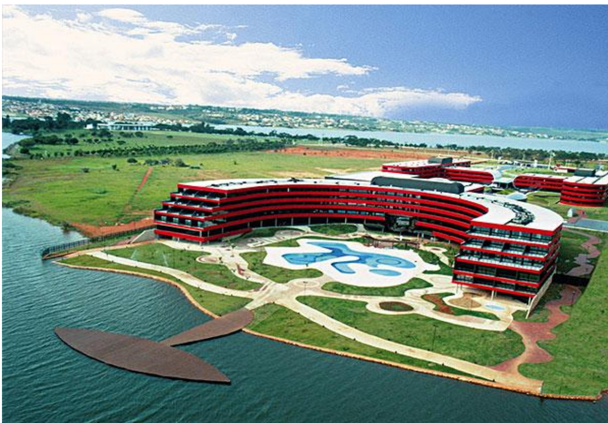
Figura 05: Vista a partir do Lago Paranoá do Complexo Hoteleiro Blue Tree, atual Brasília Alvorada Hotel.
