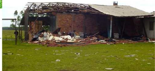
Figura 30: Sequência de fotos dos danos provocados pelo furacão Fonte: identificadas na figura
