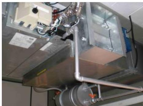
Figura 3.2 – Split dutável, damper e sistema evaporativo.
