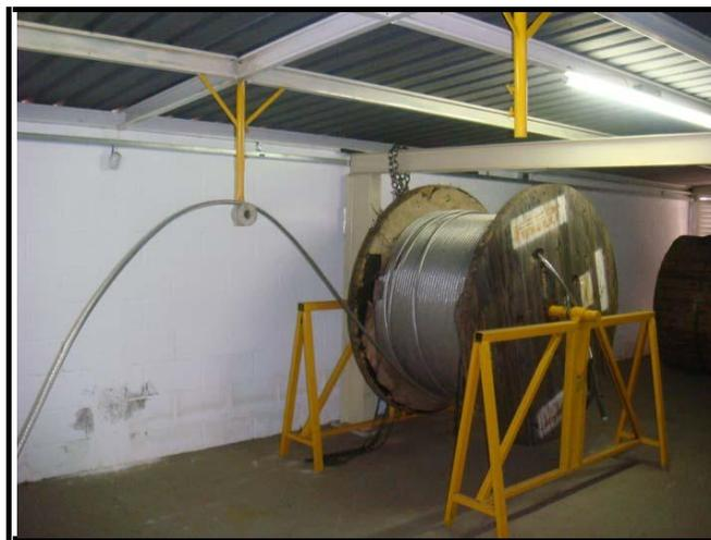
Figura 4.23 – Retirada do cabo condutor da bobina.
