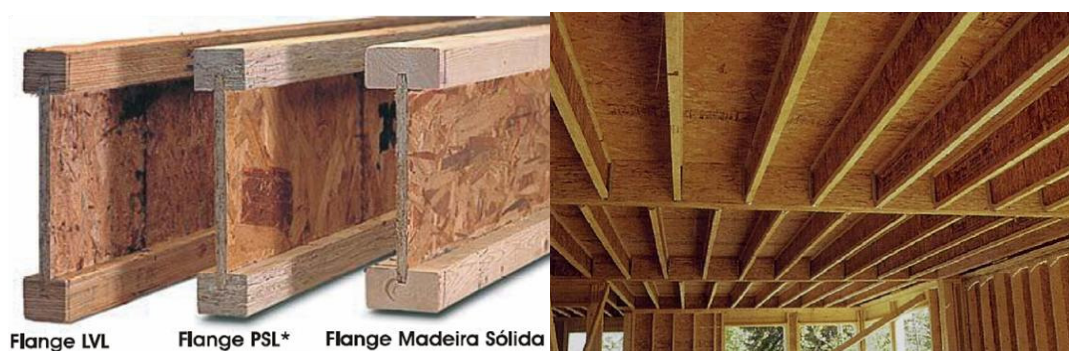
Figura 05. Exemplos da principal utilização dos painéis LVLs em flanges de vigas em seção “I” para estruturas de pisos. Fonte: Pedrosa, 2003.
