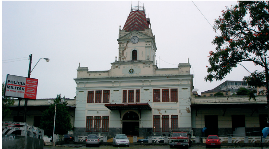
Figura 112: Vista da estação
