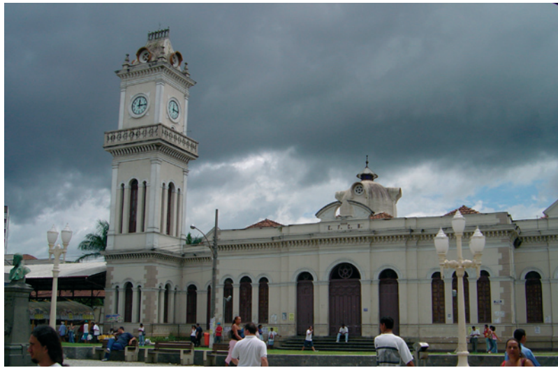
Figura 53: Vista da Estação.
