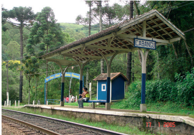
Figura 95: Vista da estação
