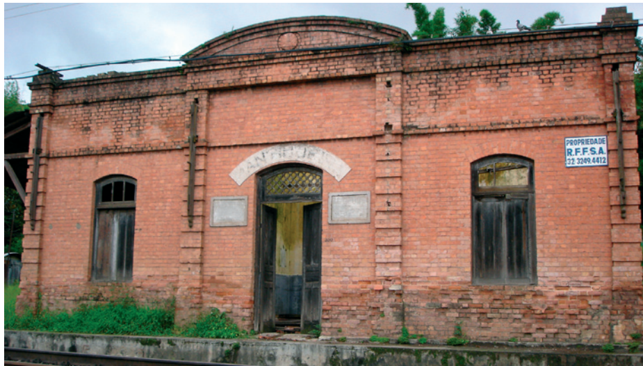
Figura 93: Vista da estação
