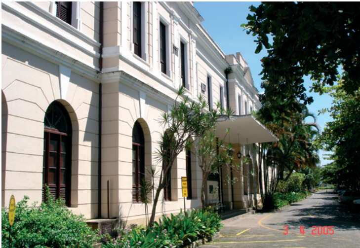
Figura 79: Vista da estação.
