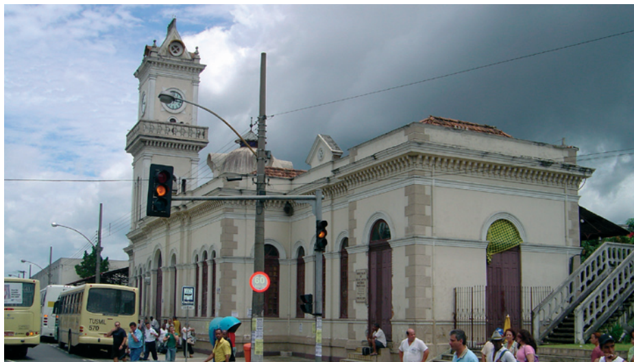
Figura 54: Vista da Estação.
