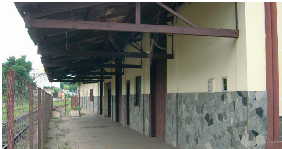
Figura 63: Vista da Estação.
