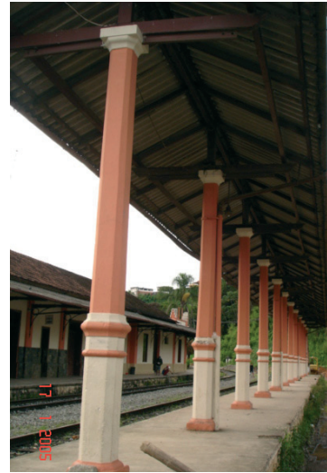
Figura 89: Vista da estação
