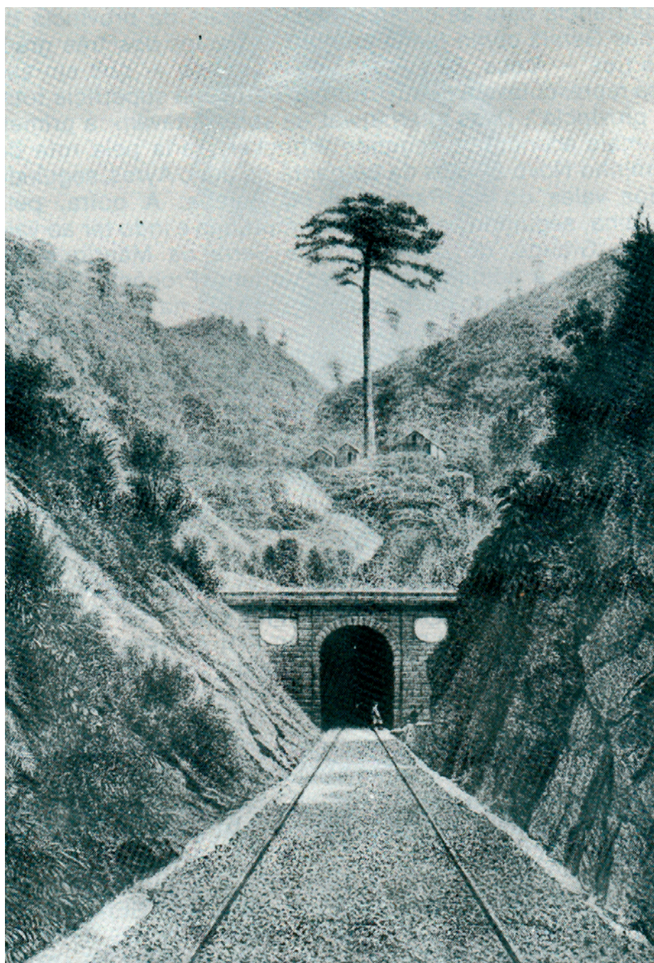
Figura 19: Boca Túnel Grande. Serra do Mar, 2.238m de extensão.
