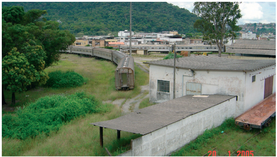
Figura 65: Vista da Estação.
