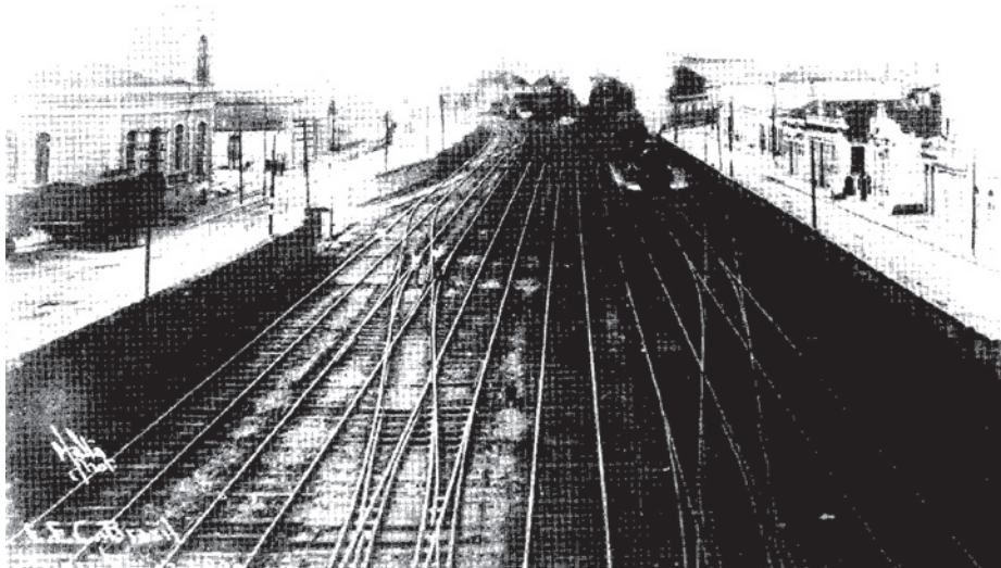
Figura 47: Pátio da Estação Central do Brasil no início do Séc. XX.
