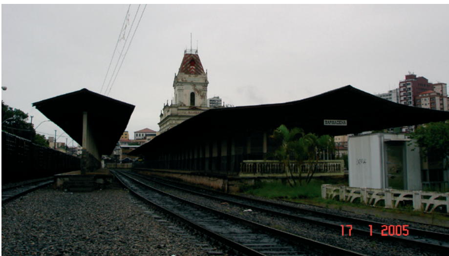
Figura 116: Vista da estação
