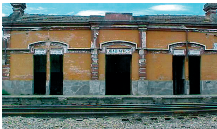
Figura 101: Vista da estação
