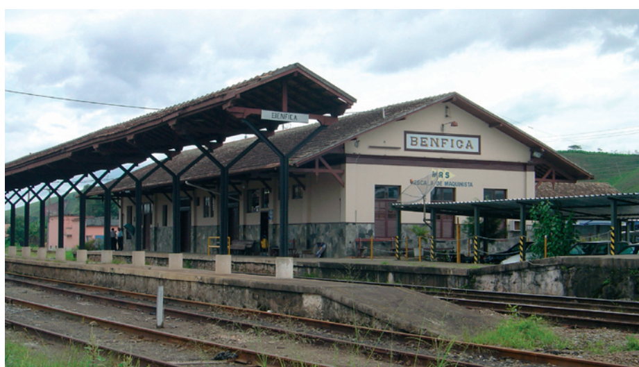
Figura 68: Vista da Estação.
