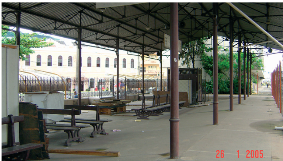
Figura 56: Vista da Estação.
