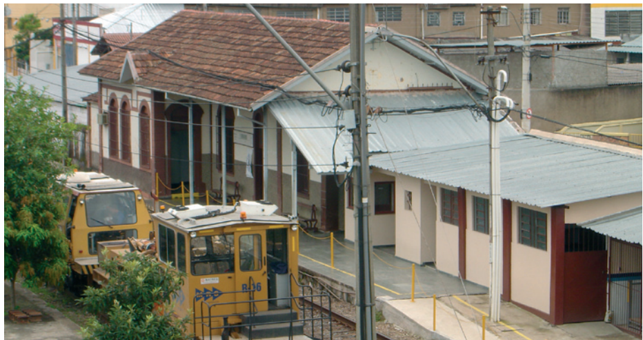
Figura 66: Vista da Estação.
