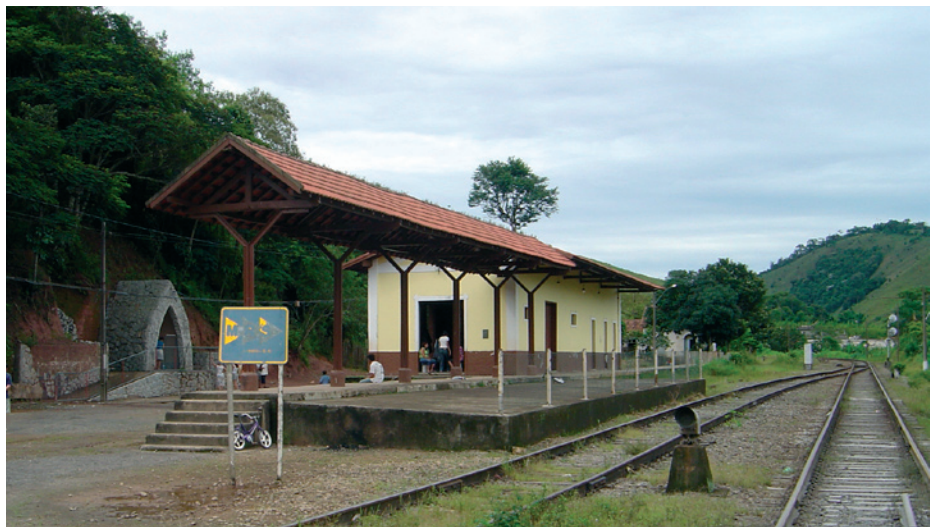
Figura 85: Vista da estação
