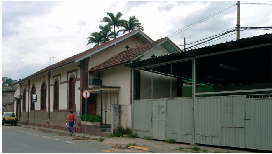
Figura 64: Vista da Estação.
