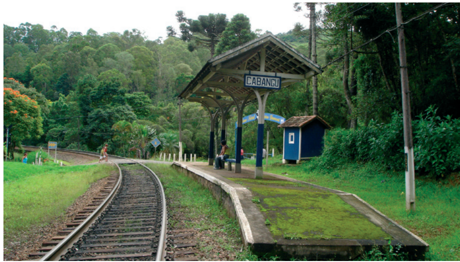
Figura 96: Vista da estação
