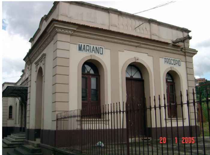
Figura 61: Vista da Estação.
