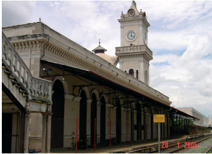
Figura 52: Vista da Estação.
