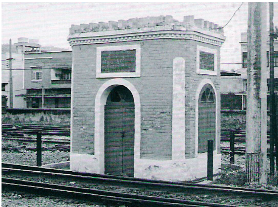
Figura 48: Guarita estrada de ferro Pedro II. 1871.
