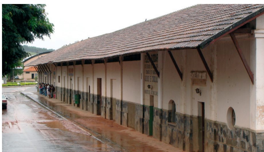
Figura 104: Vista da estação
