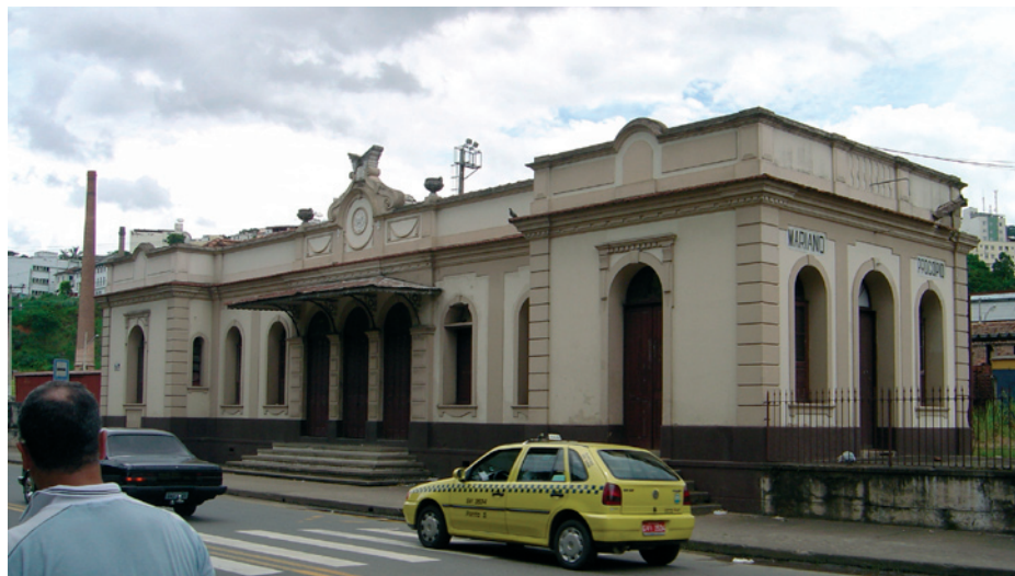
Figura 62: Vista da Estação.
