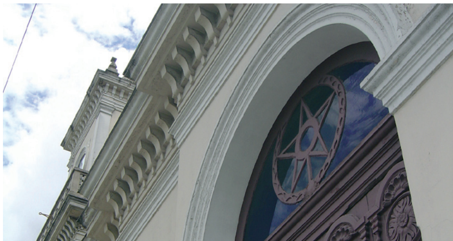
Figura 60: Vista da Estação.
