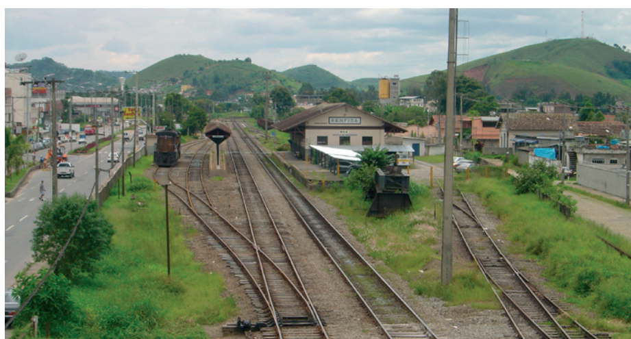
Figura 69: Vista da Estação.
