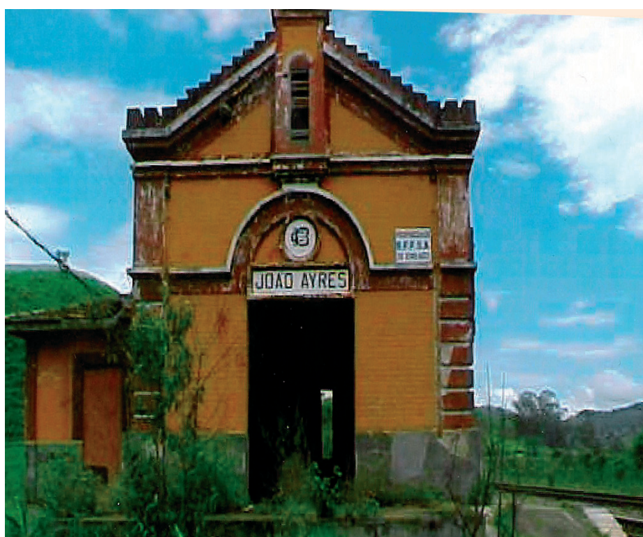
Figura 102: Vista da estação
