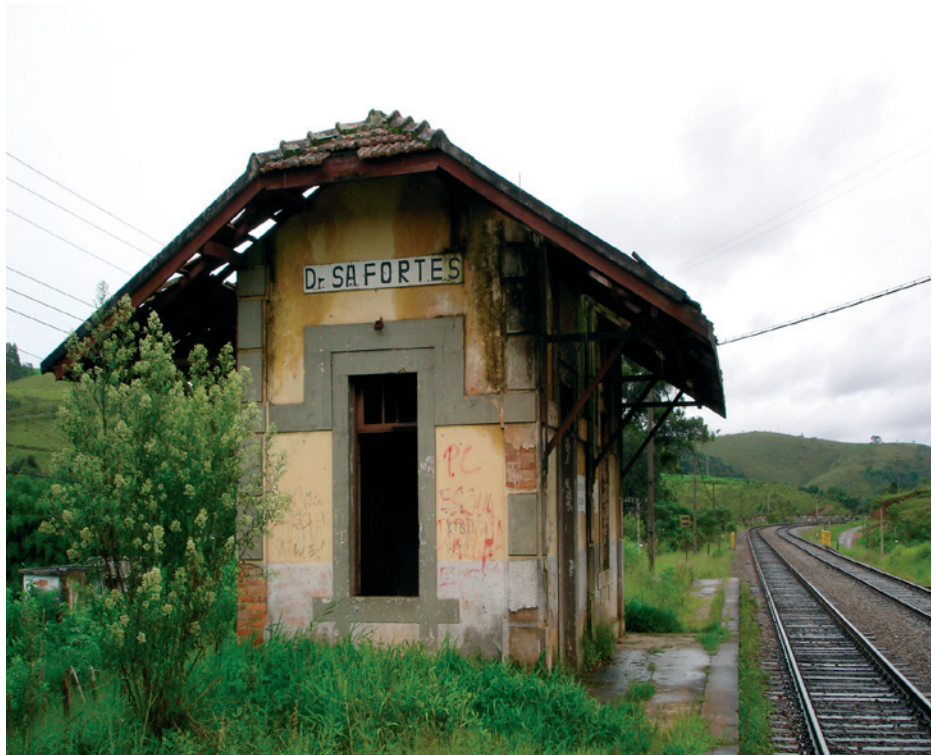
Figura 111: Vista da estação
