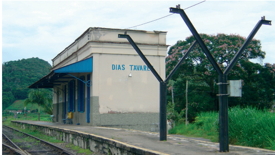
Figura 70: Vista da Estação.
