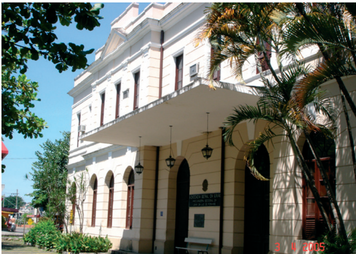
Figura 80: Vista da estação.
