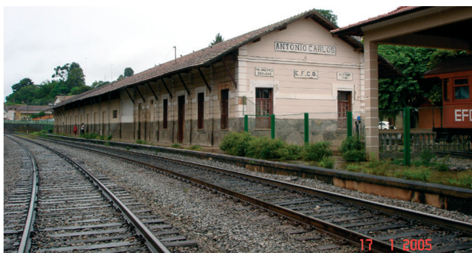
Figura 105: Vista da estação
