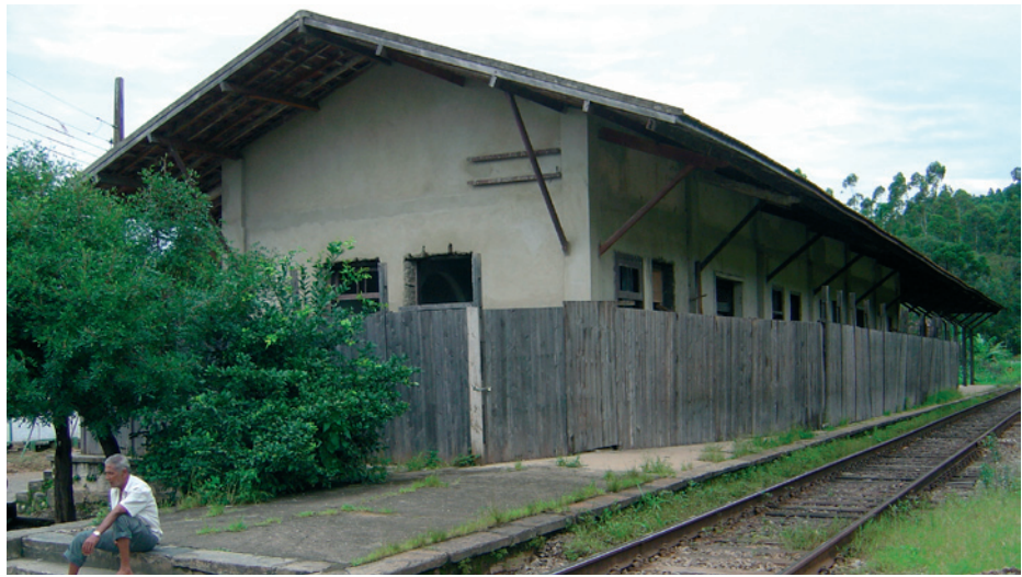
Figura 74: Vista da Estação.
