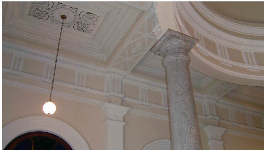
Figura 59 Vista da Estação.
