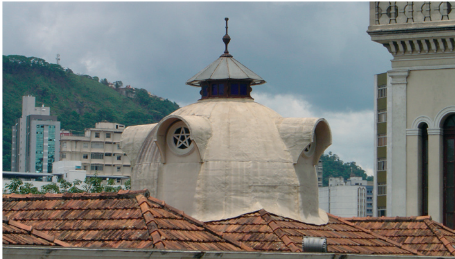
Figura 55: Vista da Estação.
