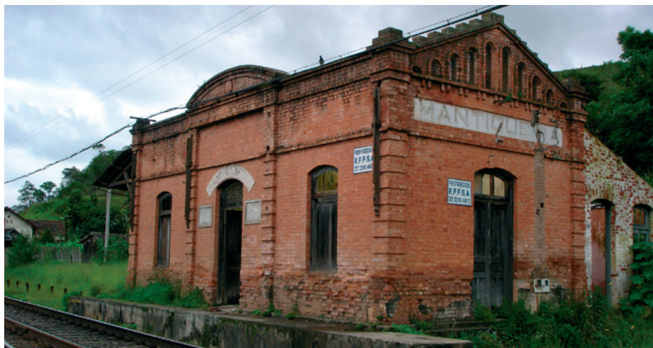
Figura 94: Vista da estação
