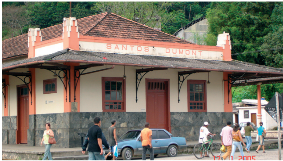
Figura 90: Vista da estação
