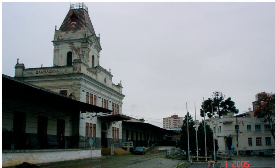
Figura 113: Vista da estação
