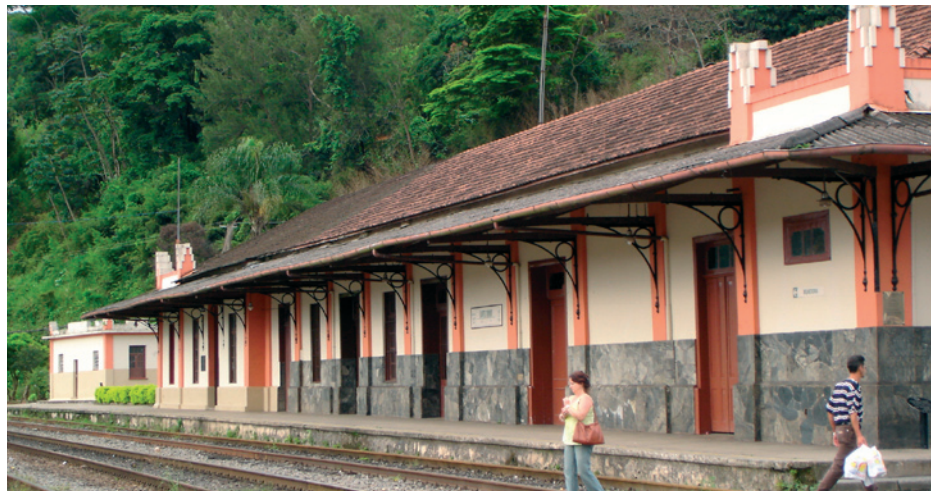
Figura 91: Vista da estação
