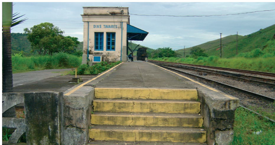
Figura 72: Vista da Estação.
