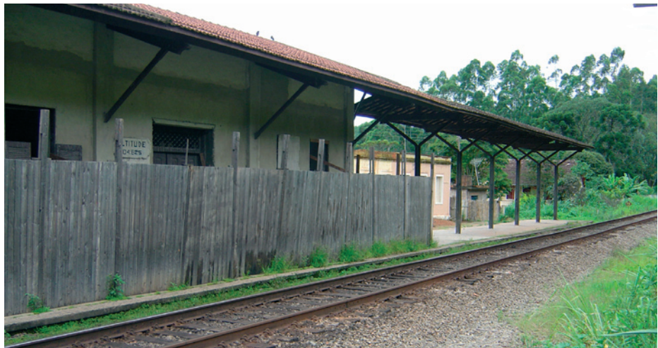
Figura 75: Vista da Estação.
