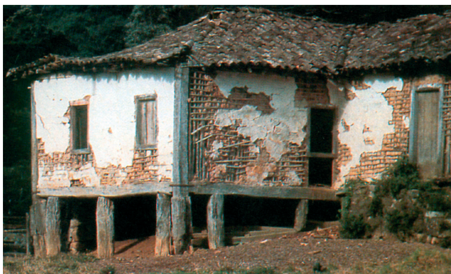
Figura 31: Casa de pau-a-pi- que com estrutura portante em ma- deira.
