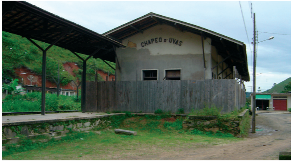
Figura 73: Vista da Estação.
