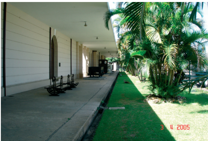
Figura 81: Vista da estação.
