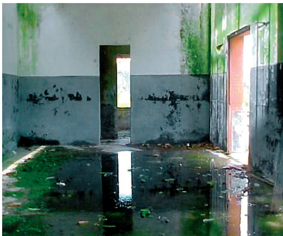
Figura 123: Estação João Ayres. Interior.
