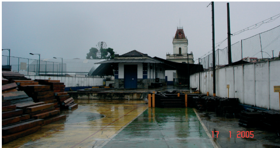
Figura 114: Vista da estação
