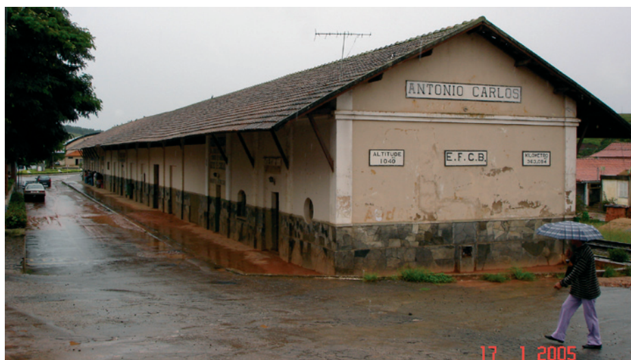
Figura 103: Vista da estação
