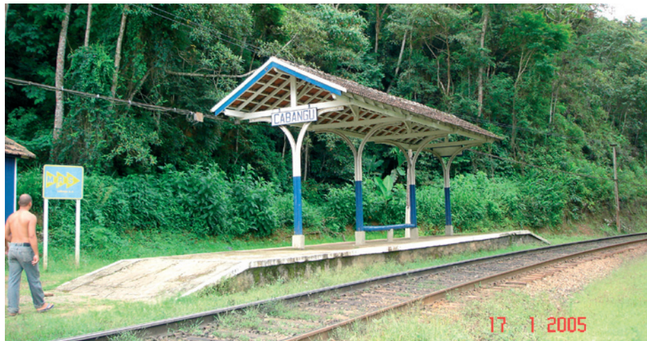
Figura 97: Vista da estação
