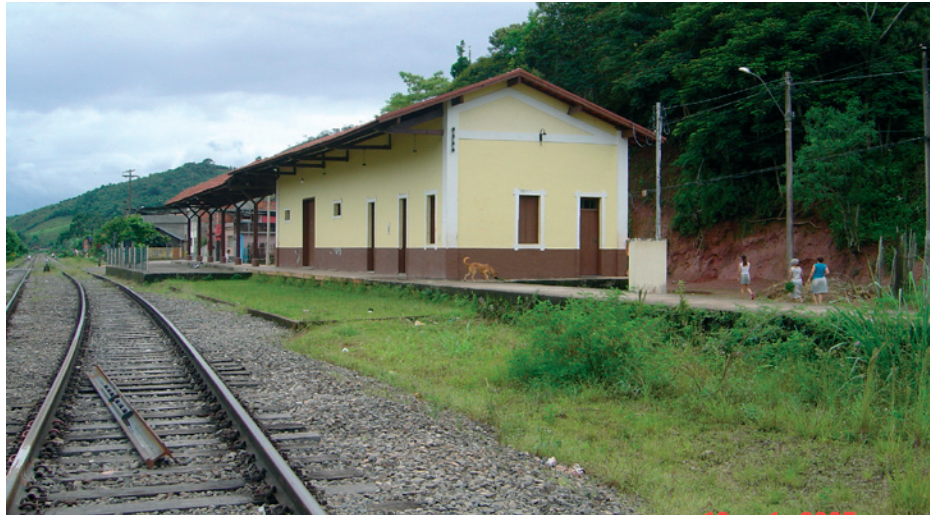
Figura 84: Vista da estação
