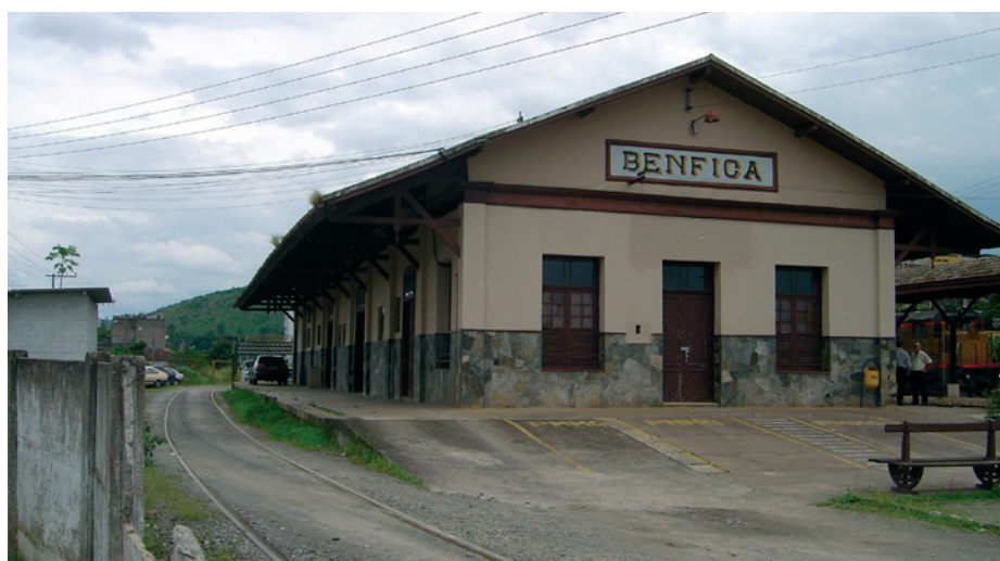
Figura 67: Vista da Estação.
