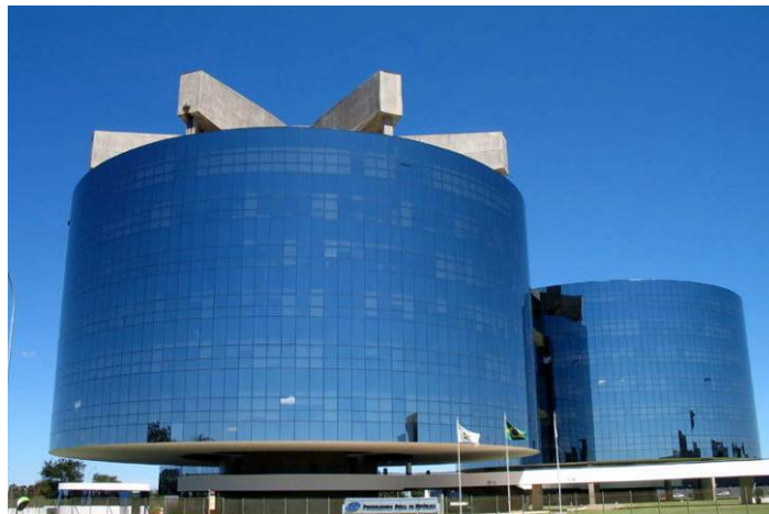
Figura 4.1 - Bloco A da Procuradoria Geral da República
