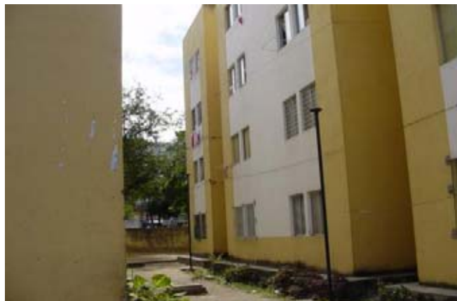
Foto 2- Conjunto Habitacional Beira Rio - Construções habitacionais para reassentamento das comunidades Arlindo Gouveia e José de Holanda removidas da margem do Rio Capiberibe.Fotos do arquivo da equipe HBB-MCidades.
