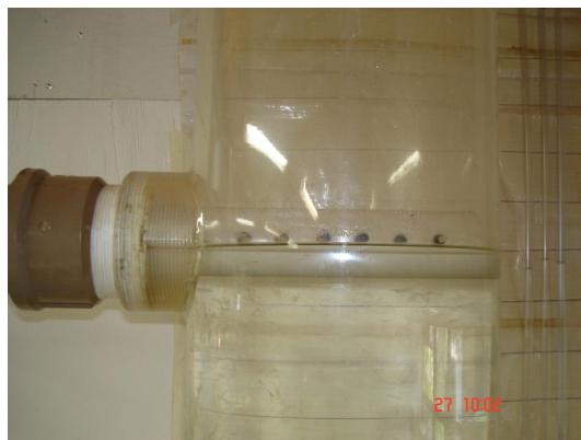
Figura 4.8 – Tubulação de saída de água do pré-filtro ascendente (PFA).
