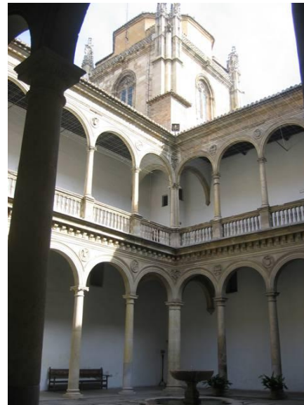
FIGURA 21 - VISTA INTERNA DA TORRE
