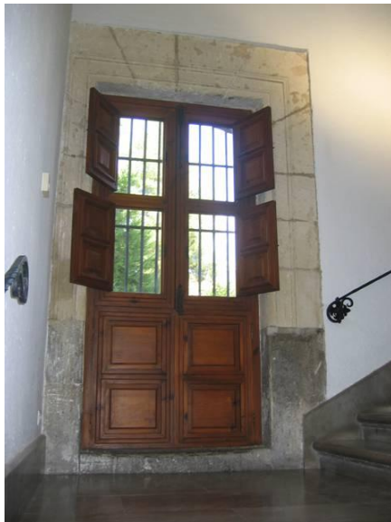
FIGURA 20 - DETALHE DAS PORTAS EXTERNAS
