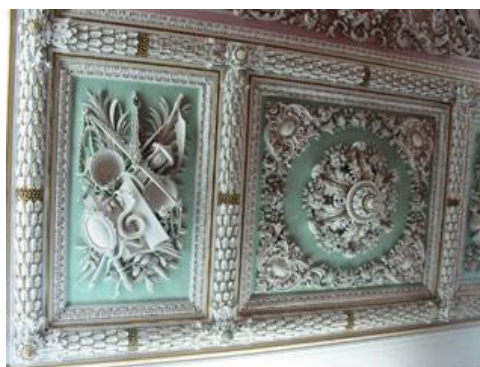
FIGURA 34 - DETALHE DO FORRO
