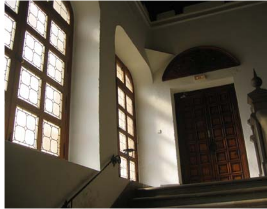
FIGURA 19 - JANELAS DAS CIRCULAÇÕES
