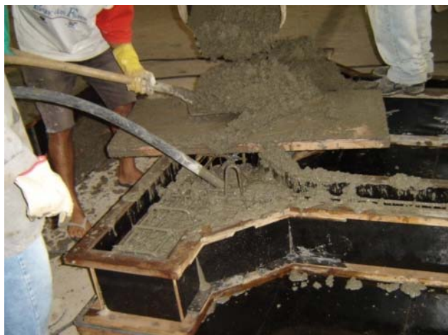
Figura 3.8 – Detalhe da concretagem e do adensamento
