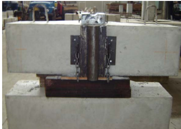
Figura 3.21 – Detalhe do aparelho de apoio
