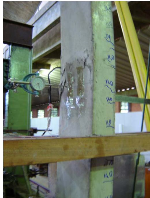
Figura 4.11 – Ruptura do pilar PFN50-3
