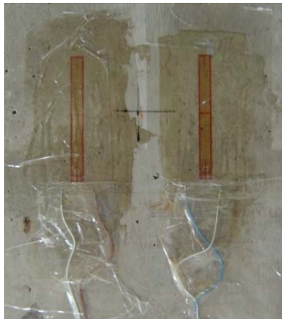
Figura 3.14 – Detalhe dos EER's colados no pilar
