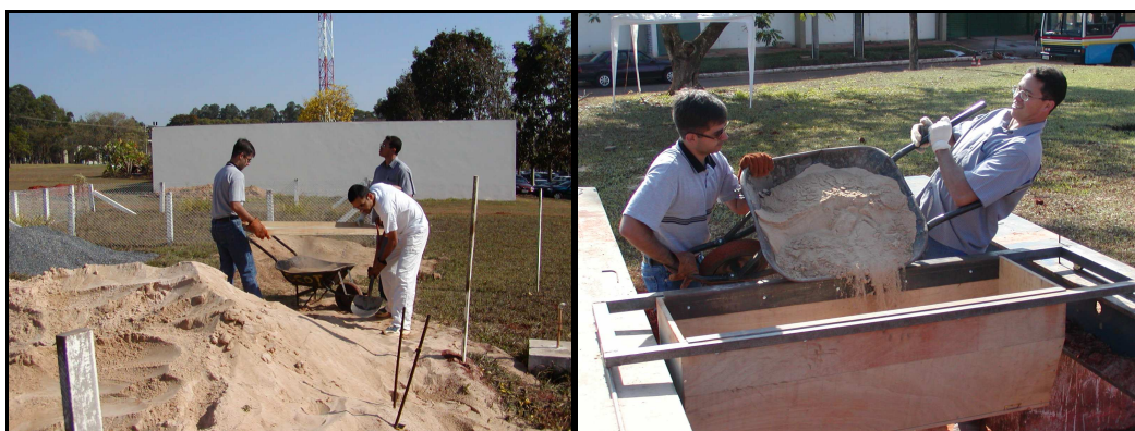
Figura 3.8 – Peneiramento e enchimento da caixa de madeira.
