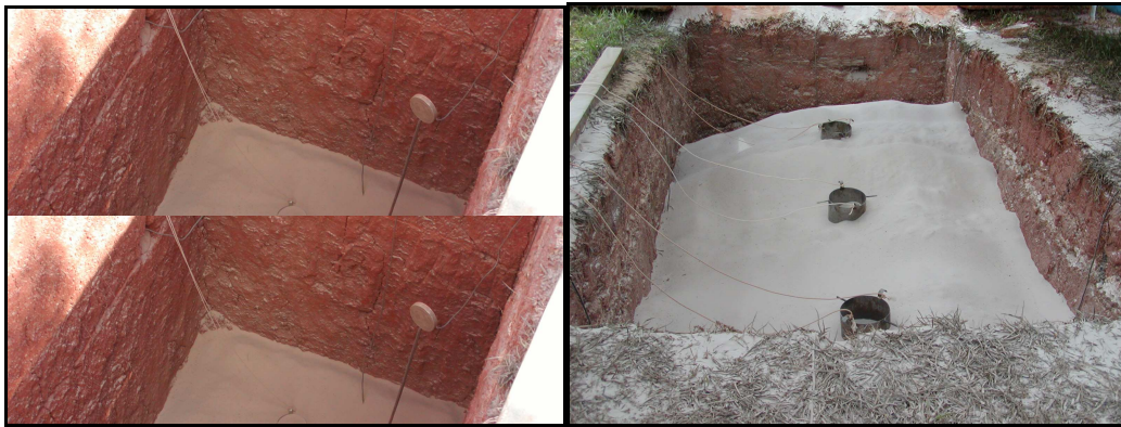
Figura 3.10 – Enchimento da vala.
