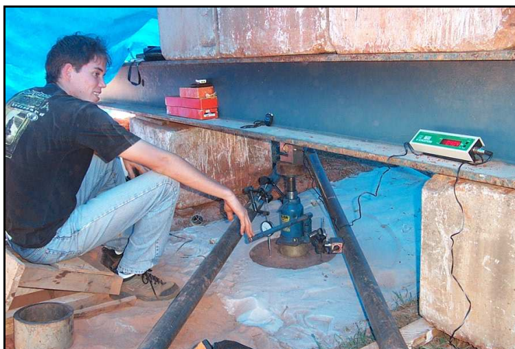
Figura 3.28 - Prova de carga sobre placa.
