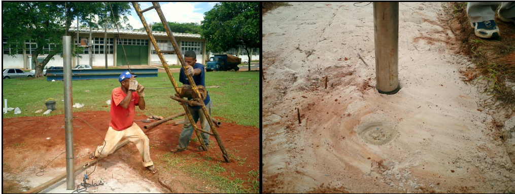
Figura 3.20 – Execução das estacas.
