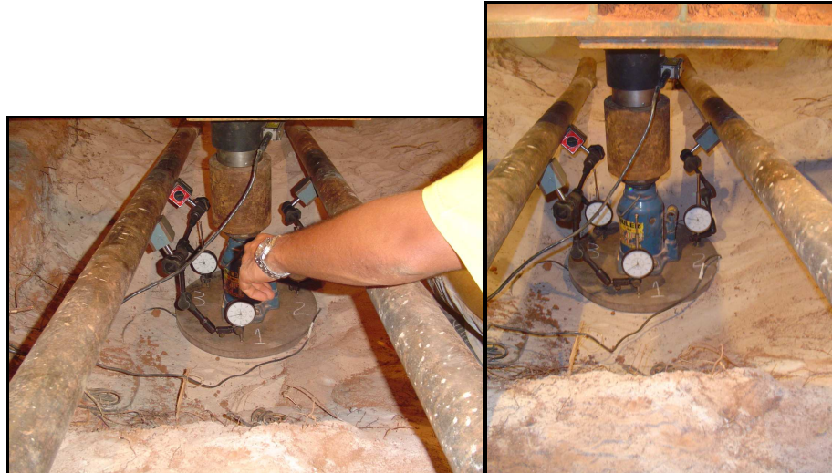
Figura 3.48 – Prova de carga no grupo de duas estacas.
