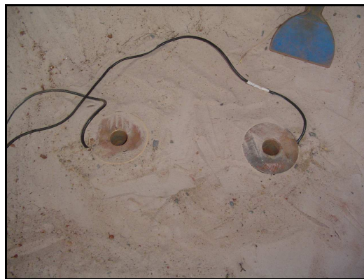
Figura 3.47 – Células de carga no grupo de duas estacas.
