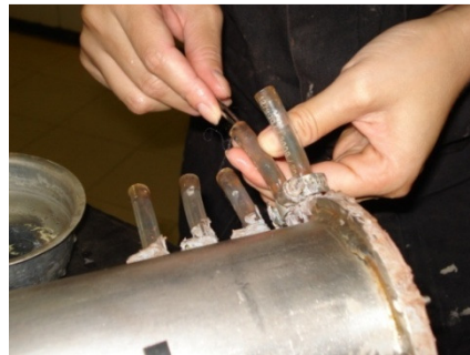
Figura 4.18. Colocação das buchas de geotêxtil nas saídas dos piezômetros.
