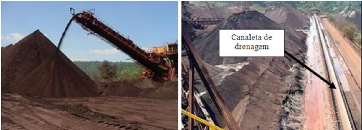
Figura 2.4. Pilha e sistema de drenagem na lateral do pátio.
