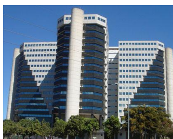
Figura 7.34 – Edifício melhor classificado na apreciação do PAF
