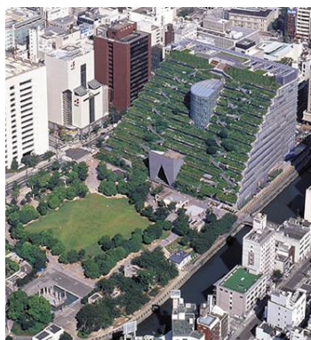
Figura 2.14 – Edifício ACROS Fukuoka 18
