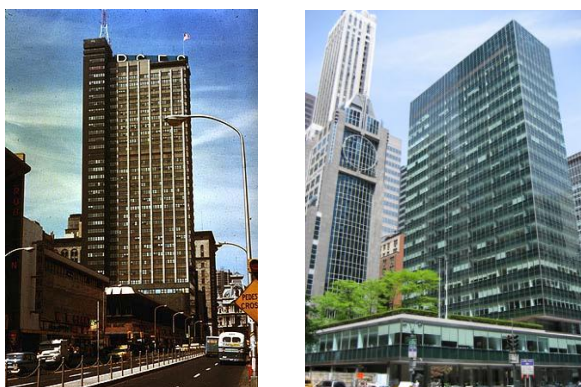
Figura 2.4 – Edifícios Philadelphia Savings Fund Society 6 e Lever House 7 , respectivamente
