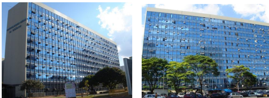
Figura 5.11 – Edifício Darcy Ribeiro
