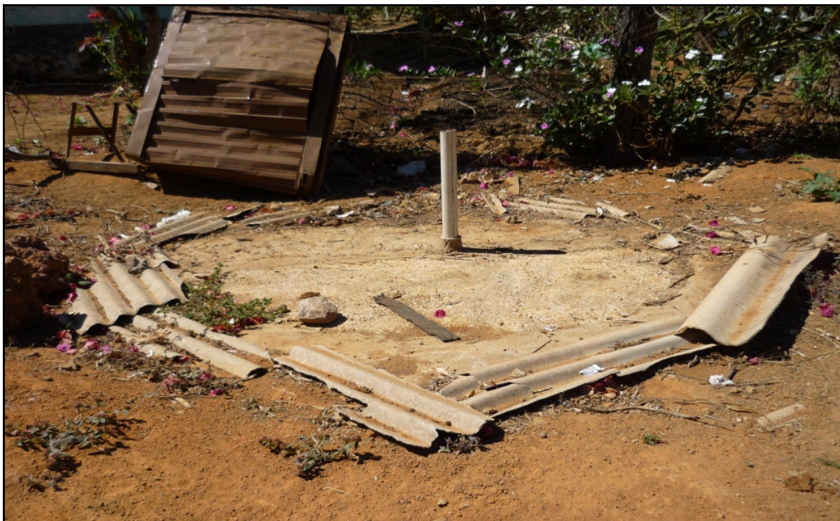
Fotografia 5 - Tipo de fossa padrão na cidade Autor: Verônica L. F. Almeida Data: 2009
