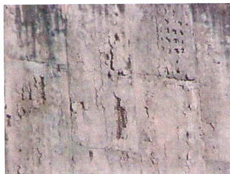
Fig. 21 – Desplacamento (Fi=3)
