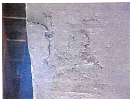
Fig. 20 – Desplacamento (Fi=2)
