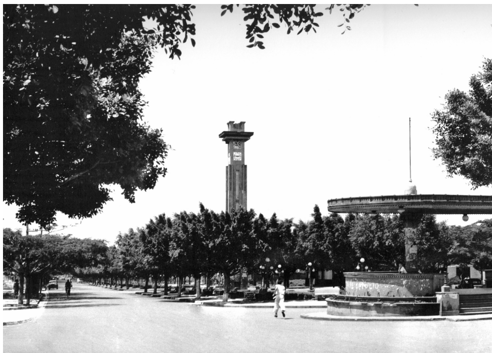
Figura 9 - Coreto, Avenida Goiás e Relógio, 1942. Fonte: Hélio de Oliveira
