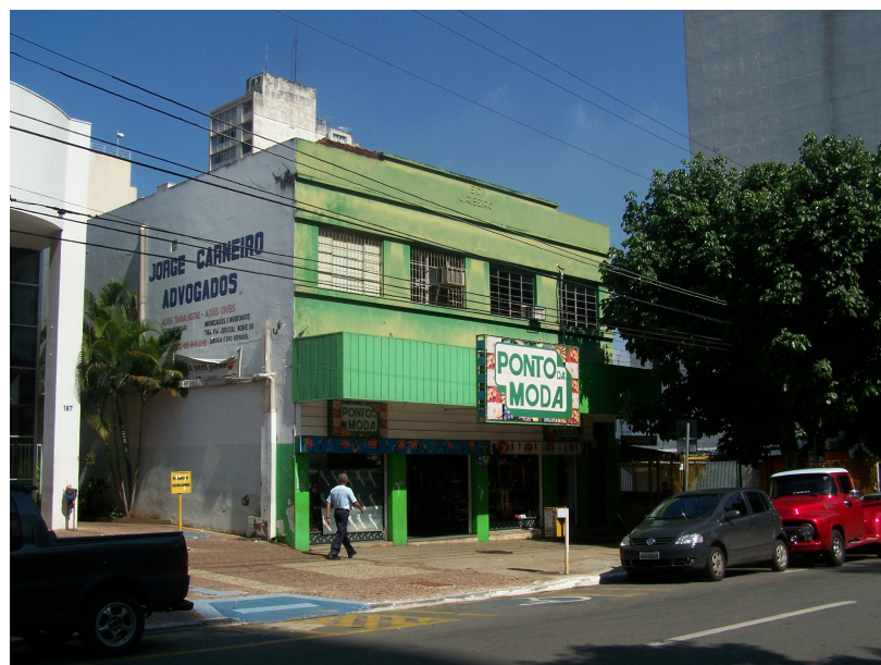
Figura 22 - Edifício J. Ribeiro, 2010. Fonte: Ary A. Veiga Filho
