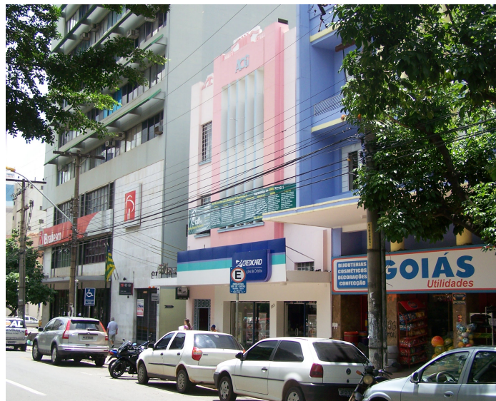
Figura 36 - Edifício restaurado, 2010. Fonte: Ary A. Veiga Filho
