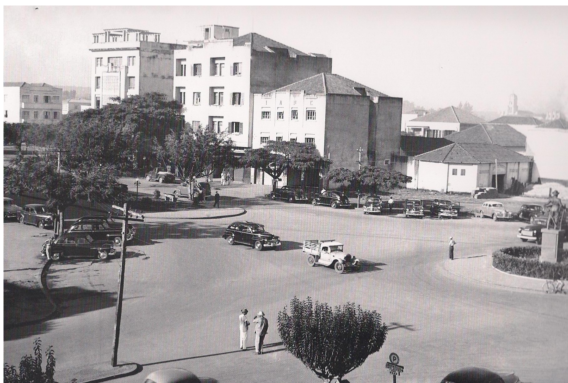
Figura 37 - Ed. Leopoldo de Bulhões - Brasserie Bar e Sorveteria. Década de 1940, (primeiro à direita).
