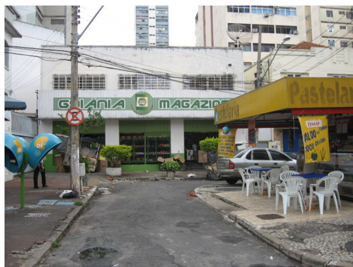
Figura 63 - Edifício GM (acesso praça), 2010.
