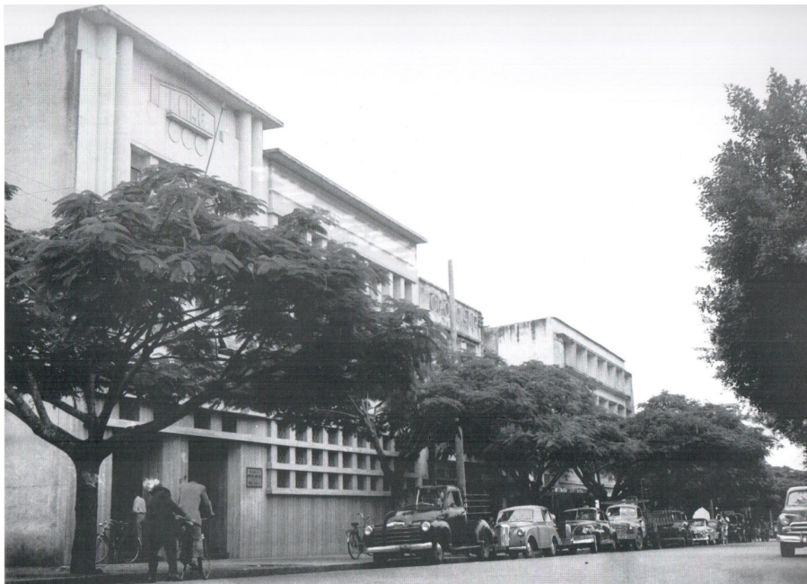
Figura 28 - Edifício O Popular, 1954. Fonte: Hélio de Oliveira
