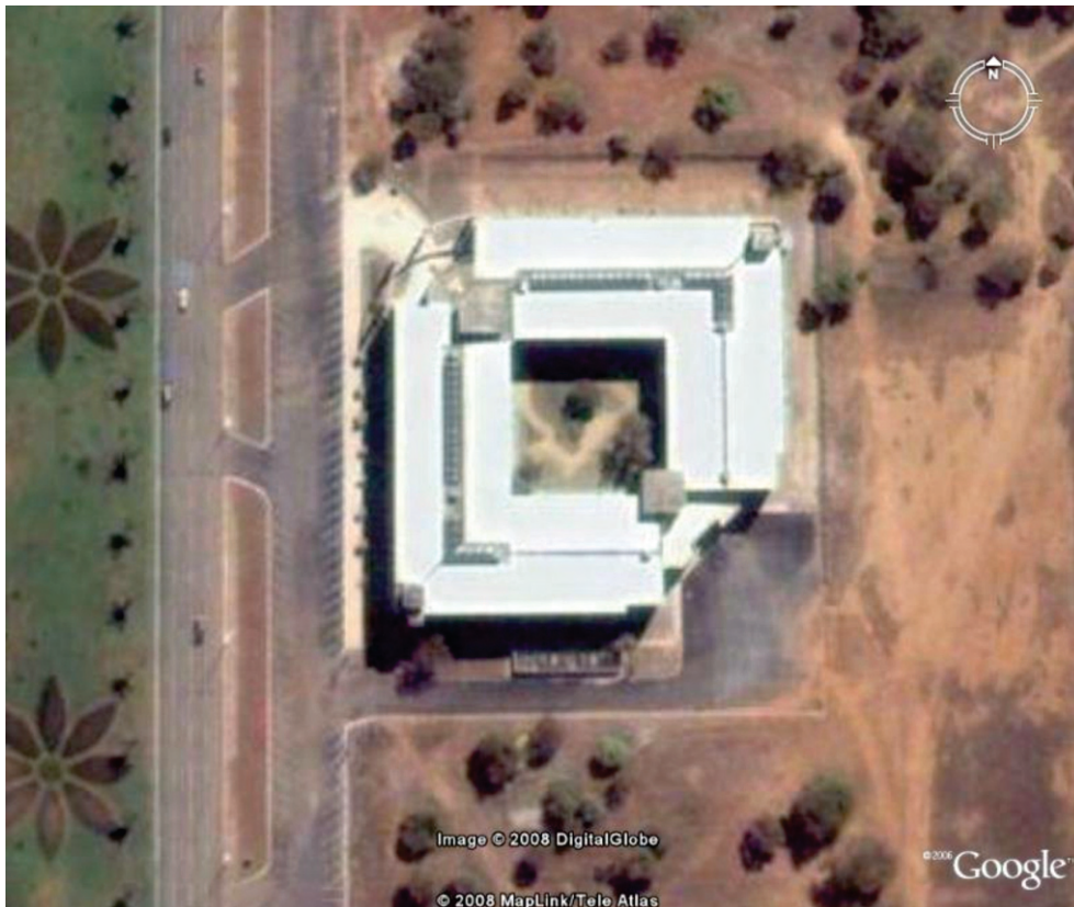
Figura 39 - Imagem aérea do edifício.
