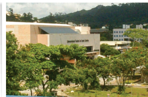
Figura 22 - VISTA DOS PAINÉIS FV NA COBERTURA CENTRO DE CONVIVÊNCIA DA UFSC. Acervo Particular
