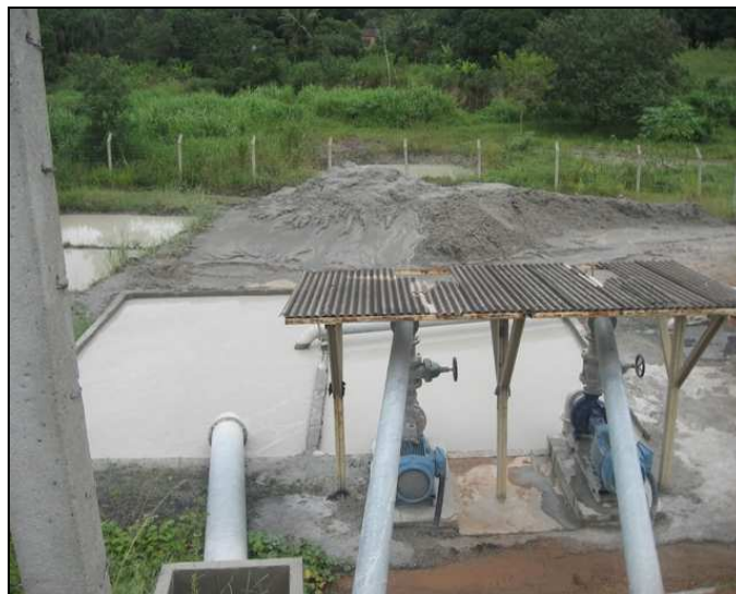
Figura 3.3. Tanque de decantação da pedreira Araguaia.
