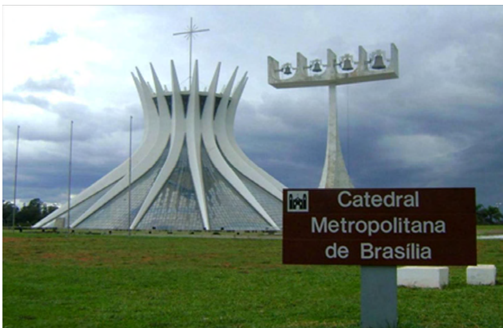
Figura 65 - Exterior 2009 Fonte: Foto da autora
