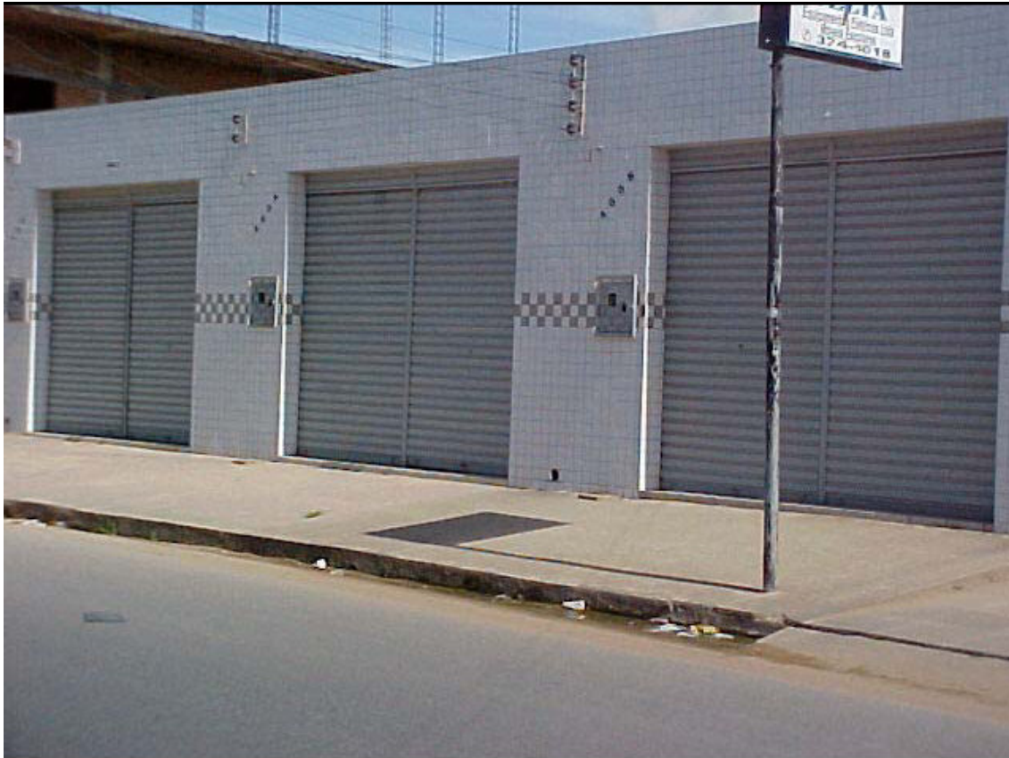
Figura 2 Fachada de falso endereço fornecido por empresa licitante de contratos públicos com verbas federais no município de Traipu, em Alagoas: empresa fantasma
