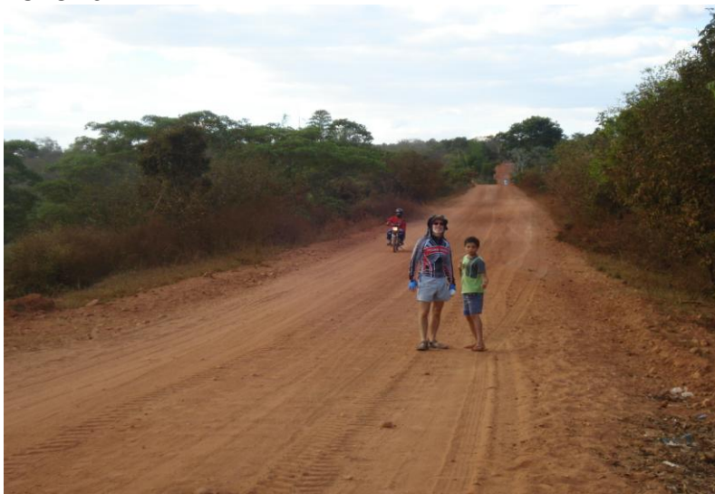
Estrada que liga o Distrito de Toricoeje (154 Km de Barra do Garças) ao município emancipado de São Joaquim (MT), a 100 Km. Tudo sem pavimentação.
