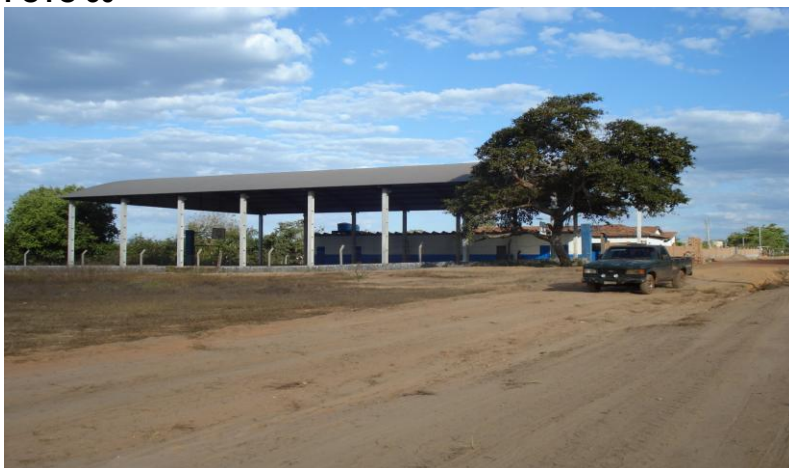
Escola Rural Miguel Sutil, com a visão da quadra coberta. Distrito de Toricoeje.
