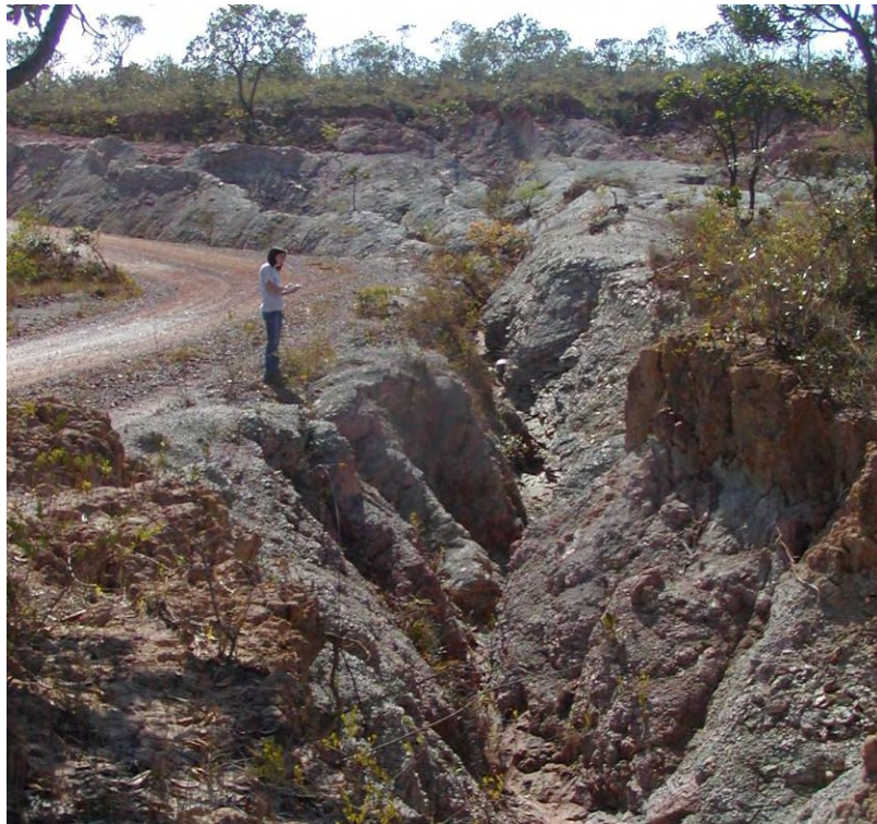
Figura E.8. Processo erosivo na lateral de estrada rural na parte intermediária da bacia.
