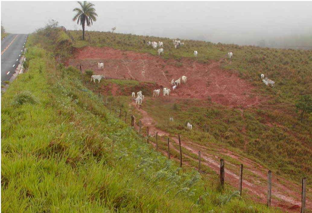
Figura E.3. Processo erosivo devido ao tráfego concentrado de gado.
