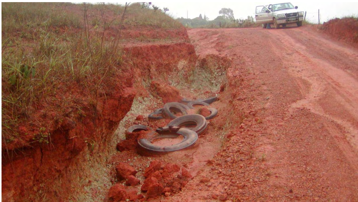
Figura E.6. Emprego de pneus na tentativa de controlar o avanço do processo erosivo, ainda em estado inicial, na lateral de uma estrada rural.
