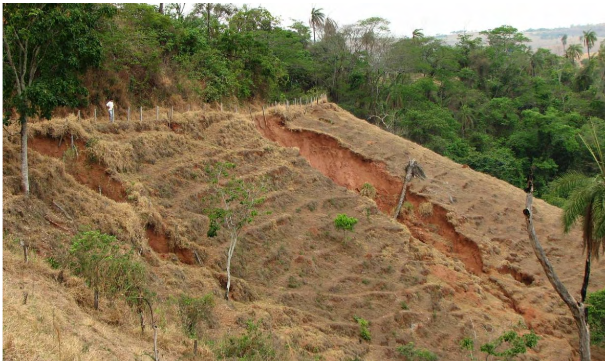
Figura E.10. Processo erosivo desencadeado pela acumulação das águas da drenagem superficial da estrada rural.
