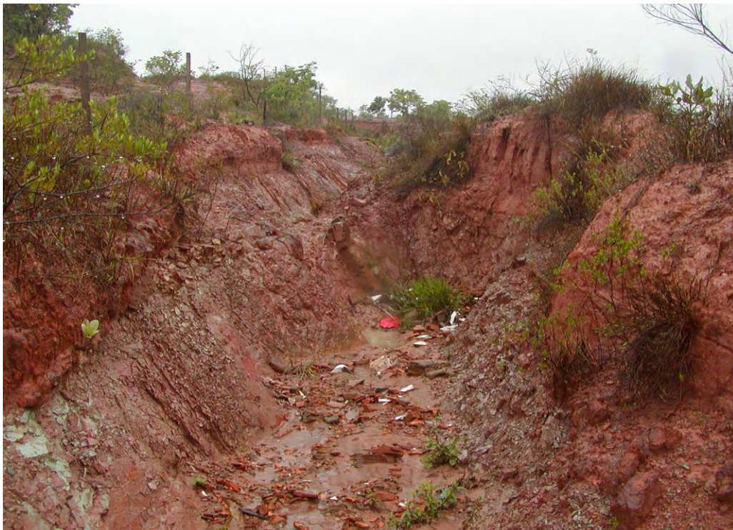
Figura E.4. Despejo de entulho no interior de uma ravina.
