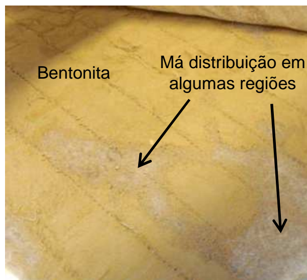
Figura 8.4 – Distribuição não uniforme da bentonita no núcleo do GCL 1.C.
