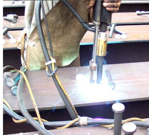
Figura 2.7 - Aplicação do conector *stud* (Kotinda, 2006)
