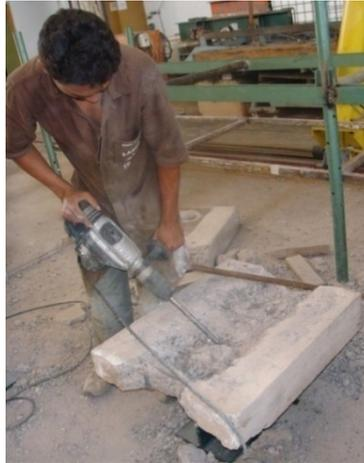
Figura 6.18 - Retirada da laje de concreto com britador elétrico
