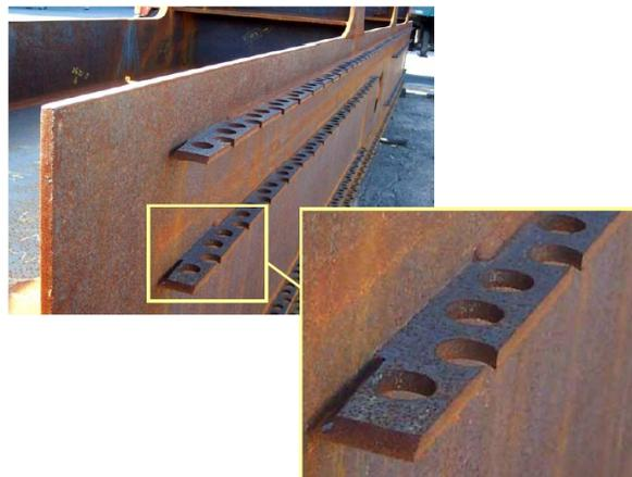
Figura 2.12 - Conector de cisalhamento do tipo ‘perfobond’ (Kotinda, 2006).
