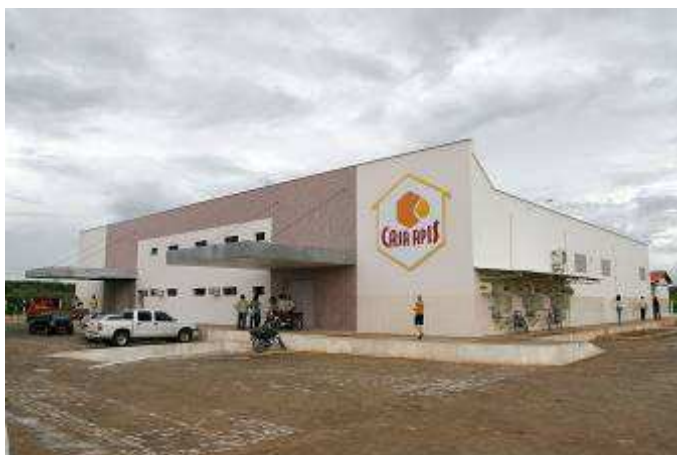
Fotografia 5 – Fachada da Casa Apis. Autor: Jeter Gomes. Data: 2009. Fonte: FBB (2010).
