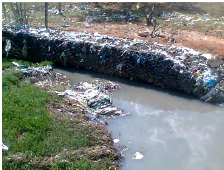
Figura 22 – Encontro do esgoto clandestino com as margens do córrego Fumal. Autoria: Amig@s do Parque Sucupira.
