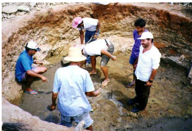
Foto 8- Solânea (PB): Agricultores participam de curso para construir cisternas de placas. Autor: VAZ, C. F. (jun./2008)
