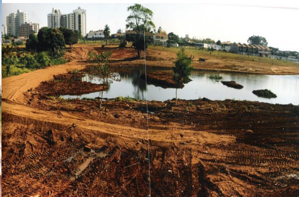
FOTO 02 Parque Vaca Brava Obras de Implantação no final de 1995
