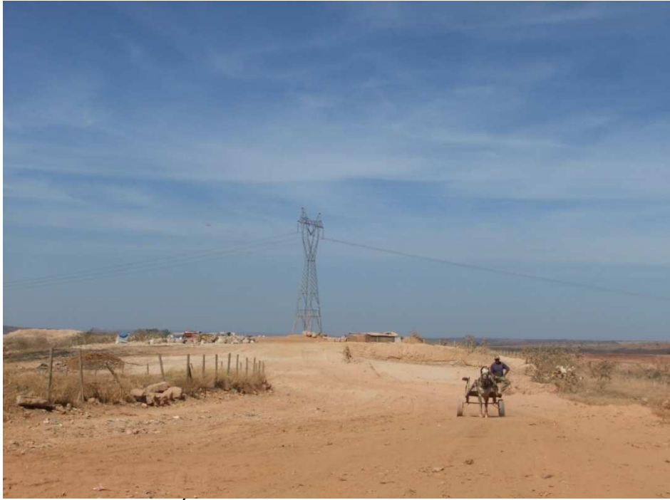
Figura 8.4: Lixão de Águas Lindas de Goiás
