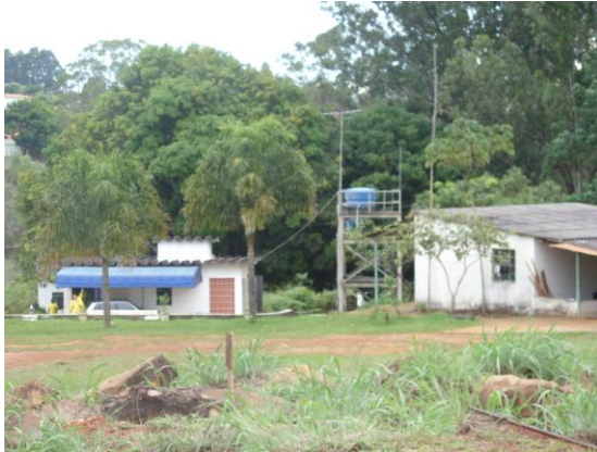
(a) Prédios da base de apoio do ICMBio, à direita, e da CAESB, à esquerda.
