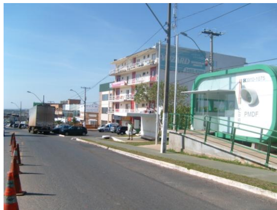
(d) Posto Comunitário de Segurança, localizado no Grande Colorado.
