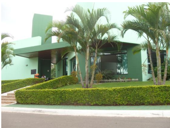
(a) Frente do Condomínio Bela Vista, no Bairro Grande Colorado.
