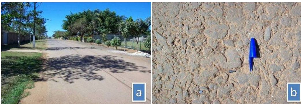
Figura 2.9 - (a) Fresado usado como revestimento; (b) Detalhe do revestimento.
