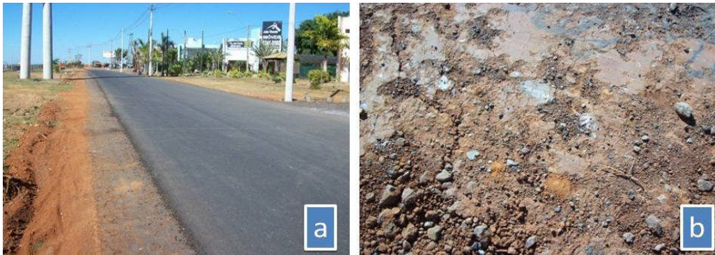
Figura 2.8 - (a) CBUQ construído sobre base de solo-fresado; (b) Detalhe da base solo+fresado.
