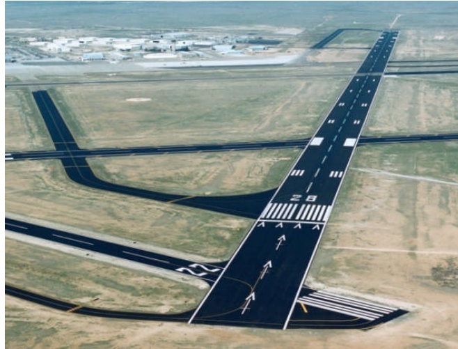
Figura 2.18 - Pista de aeroporto no Texas, USA, tratada com RejuvaSeal (Mah, 2006).
