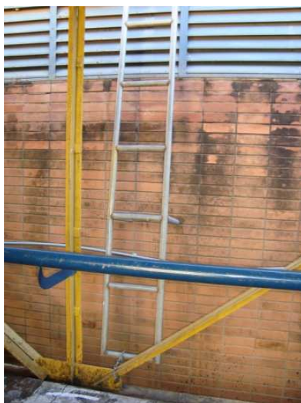
Figura 4.69 – Escada que dá acesso a cobertura do prédio
