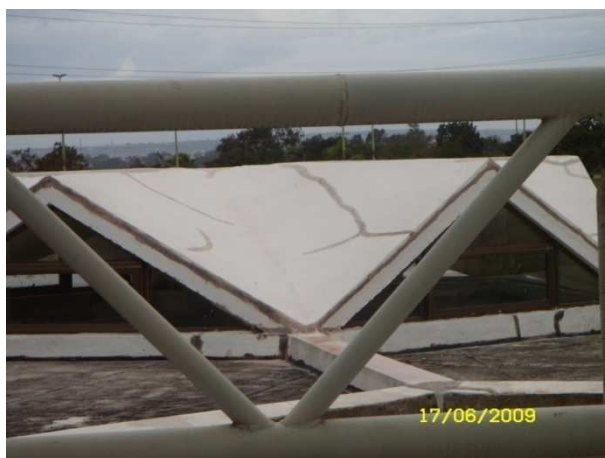
Figura 4.16 – Sheds da laje de cobertura do almojarifado do IQ
