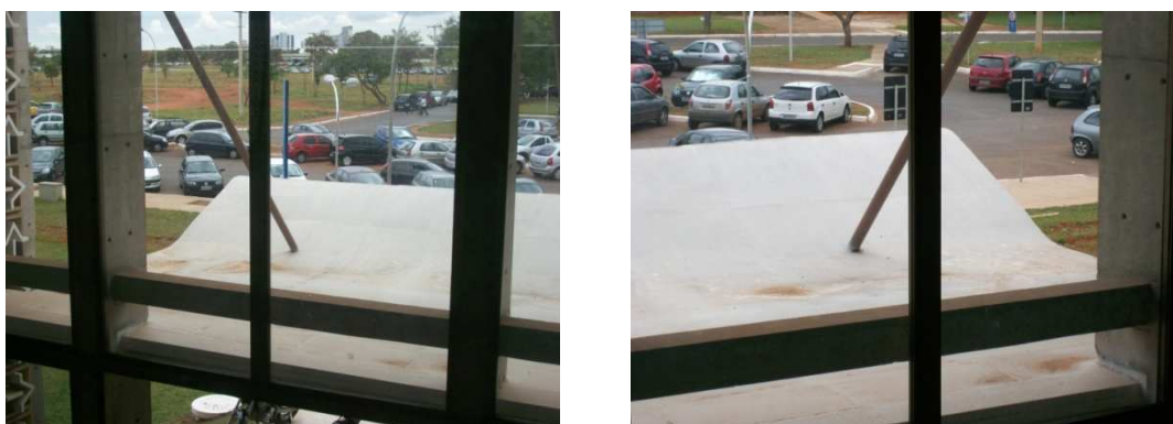
Figura 4.9 – Marquise localizada na entrada do prédio IQ
