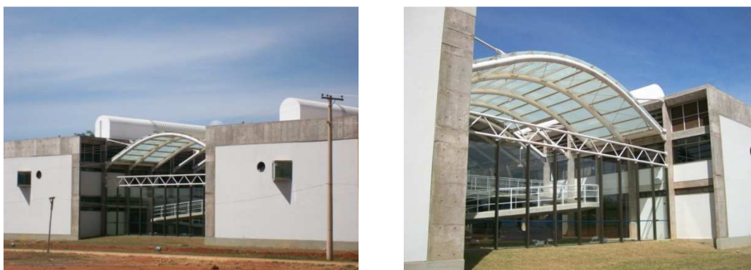
Figura 4.5 – Detalhe da cobertura do IQ
