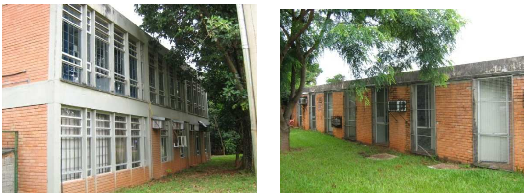
Figura 4.29 – Esquadrias do prédio (FT)
