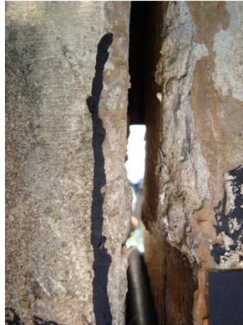
Figura 4.73 – Junta de dilatação entre pilares sem nenhum material de enchimento
