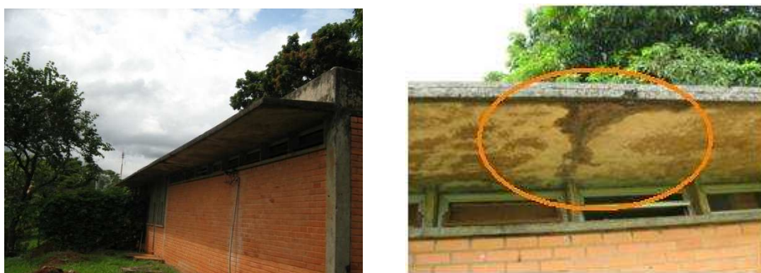
Figura 4.31 – Marquises localizadas na fachada do prédio (FT)
