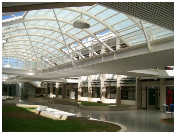
Figura 4.10 – Estrutura metálica localizada no interior do prédio do IQ
