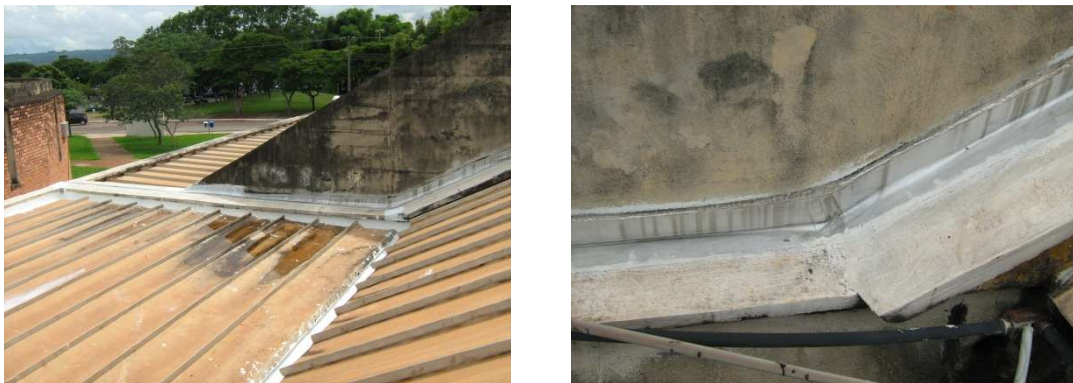
Figura 4.45 – Rufos metálicos nos encontros dos elementos da cobertura
