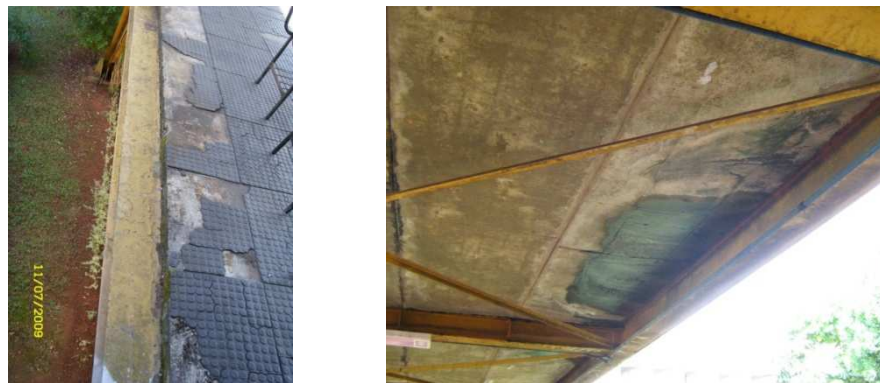
Figura 4.68 – Passagem da umidade pelo encontro laje-viga
