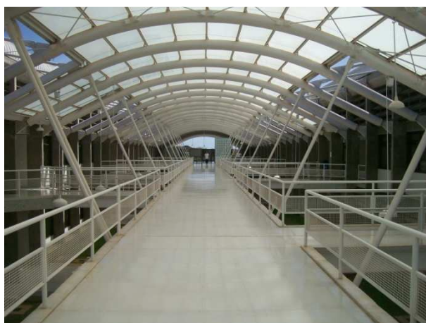
Figura 4.17 – Passarela localizada no IQ
