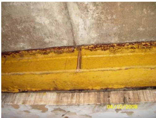
Figura 4.62 – Elementos da passarela em estado de corrosão
