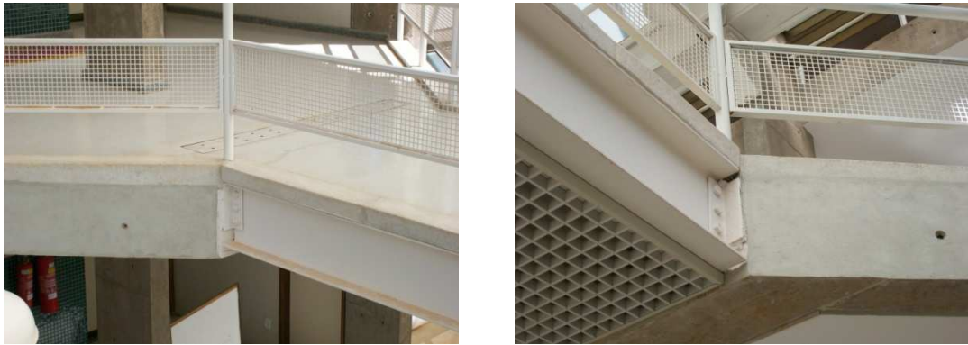
Figura 4.22 – Ligação entre a viga metálica da passarela e a viga de concreto do prédio
