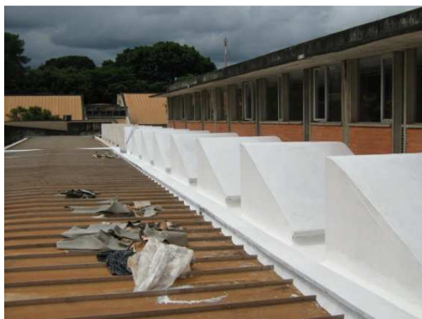
Figura 4.42 – Sheds de concreto localizados na cobertura do prédio da FT
