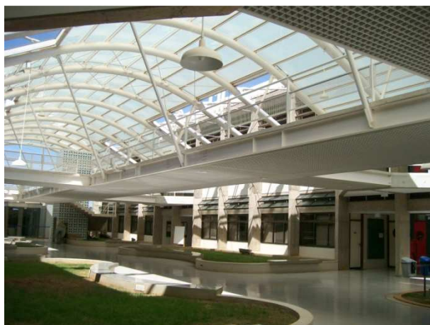
Figura 4.18 – Vigas e tirantes de aço da passarela do IQ
