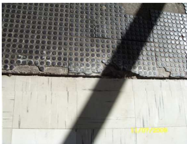
Figura 4.66 – Junta de dilatação entre o prédio e a passarela (vista pela parte superior)
