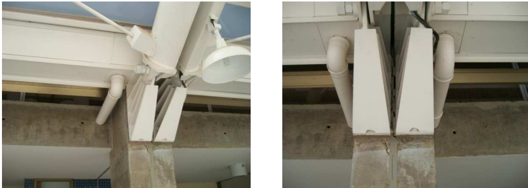
Figura 4.6 – Detalhe do sistema de drenagem do IQ
