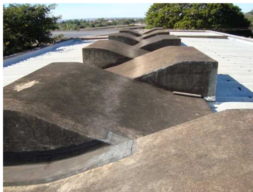
Figura 4.71 – Impermeabilização entre os sheds
