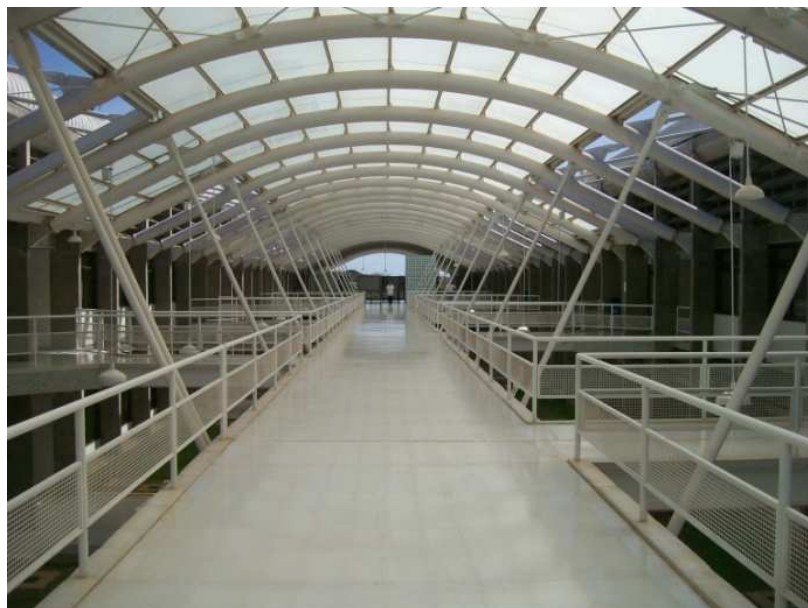
Figura 4.4 – Corredor central do pavimento superior do IQ
