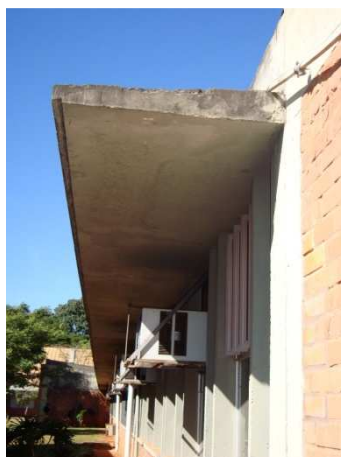
Figura 4.36 – Marquise localizada no interior do FT
