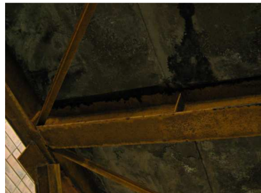
Figura 4.62 – Elementos da passarela em estado de corrosão
