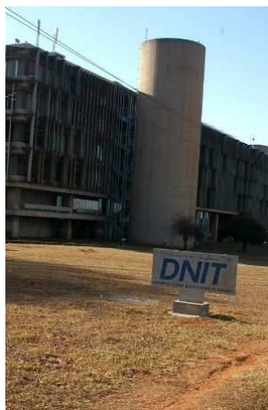
Figura 3.12 – Fachada do prédio do DNIT com vários brises de concreto
