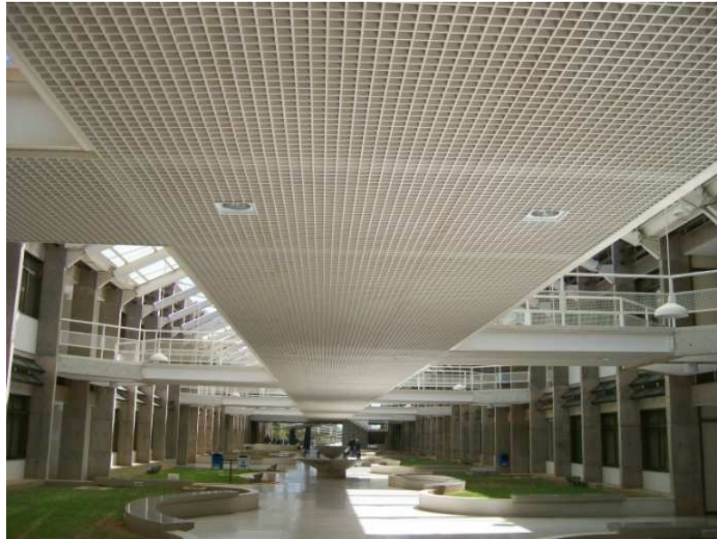
Figura 4.3 – Corredor central do pavimento térreo do IQ
