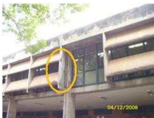
Figura 4.59 – Demolição de dois brises
