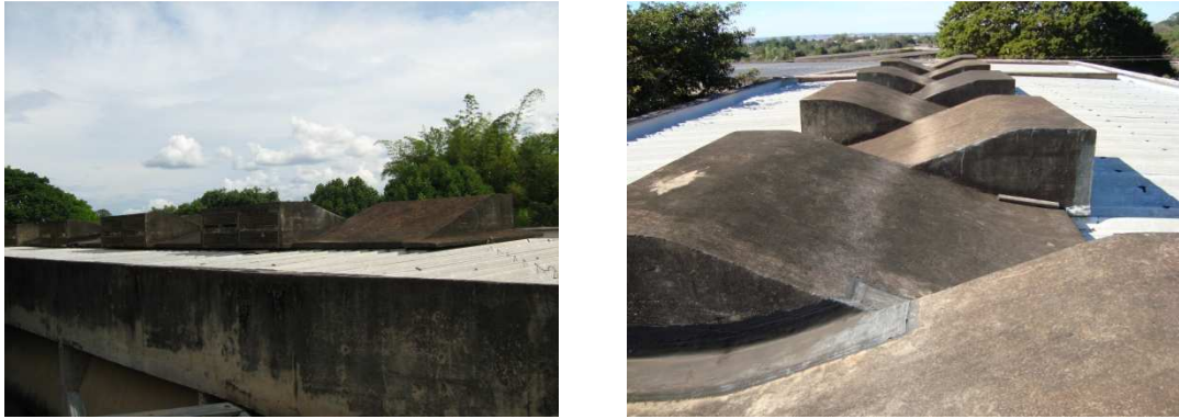
Figura 5.6 – Sheds de concreto (Lessa e Nóbrega, 2009).
