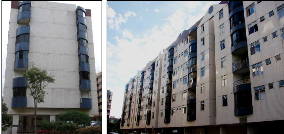
Figura 4.6 – Fotos das fachadas nordeste (esquerda) e noroeste (direita) do edifício A.
