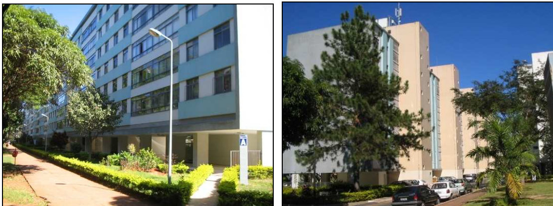
Figura 4.10 – Fotos das fachadas sudeste (esquerda) e noroeste (direita) do edifício B.
