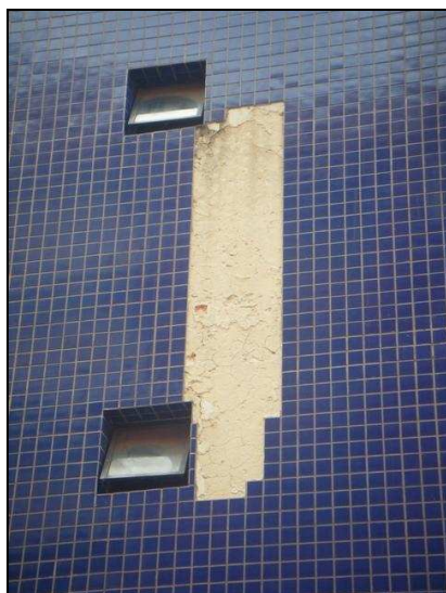
Figura 5.35 – Região com deslocamento.
