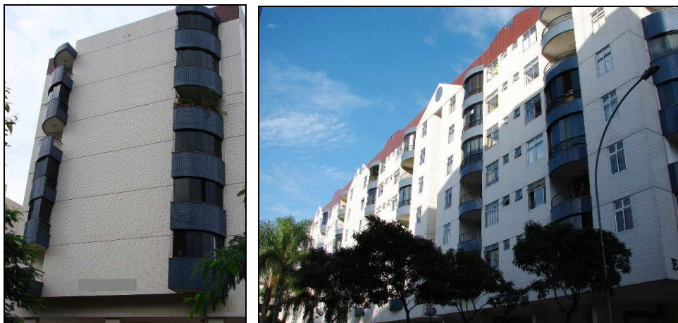
Figura 4.7 – Fotos das fachadas sudoeste (esquerda) e sudeste (direita) do edifício A.
