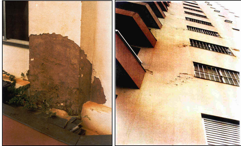
Figura 2.40 – Detalhes de desagregação (Elton Bauer, arquivo pessoal).
