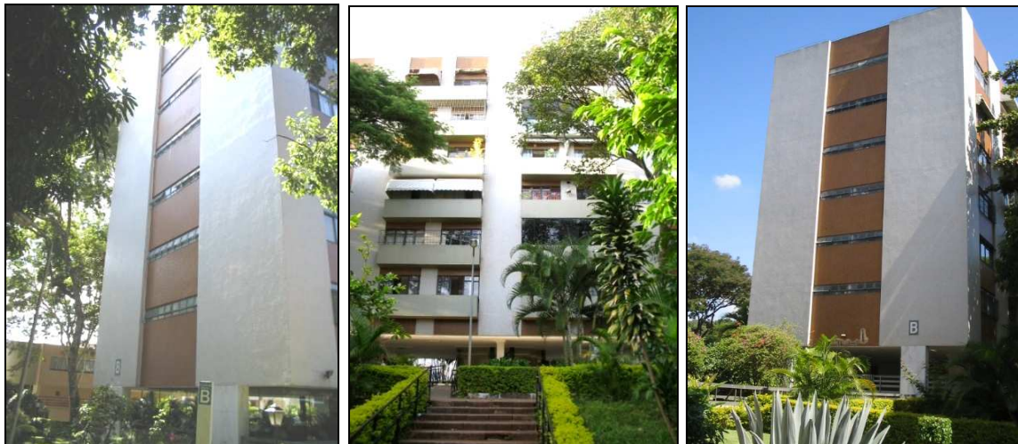
Figura 4.14 – Fotos das fachadas oeste (esquerda), norte (centro) e leste (direita) do edifício C.
