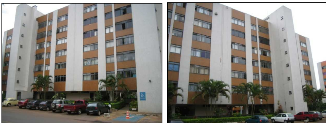
Figura 4.15 – Fotos representativas da fachada sul do edifício C.
