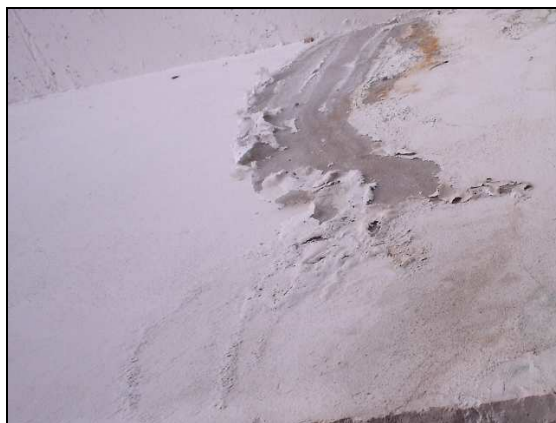
Figura 2.44 – Descascamento de pintura (LEM- UnB, arquivo fotográfico).
